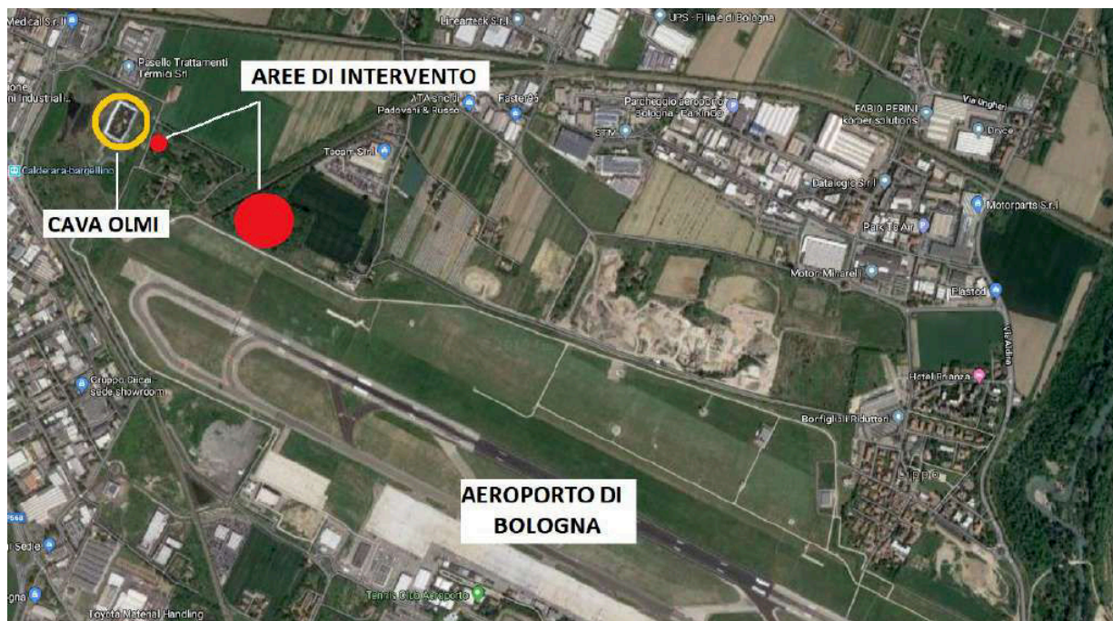
Area di intervento
