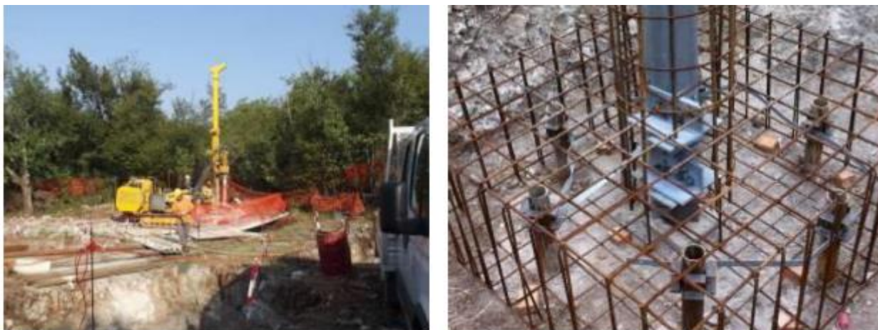
Figura 3-34- Esempio realizzazione micropali
