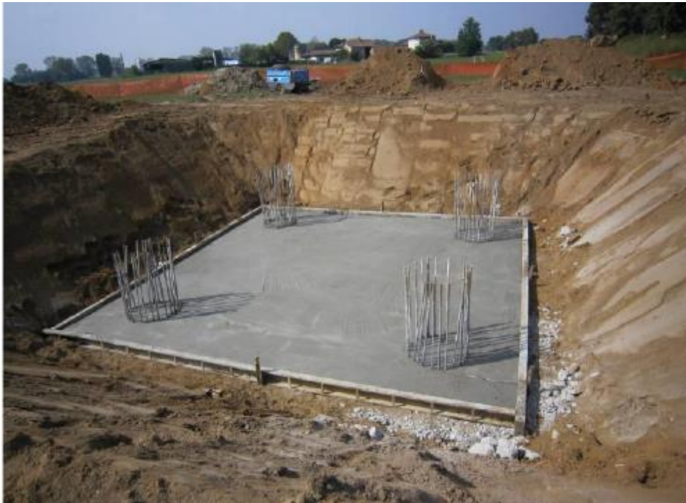
Figura 3-32- Realizzazione di una fondazione su pali trivellati per un sostegno monostelo
