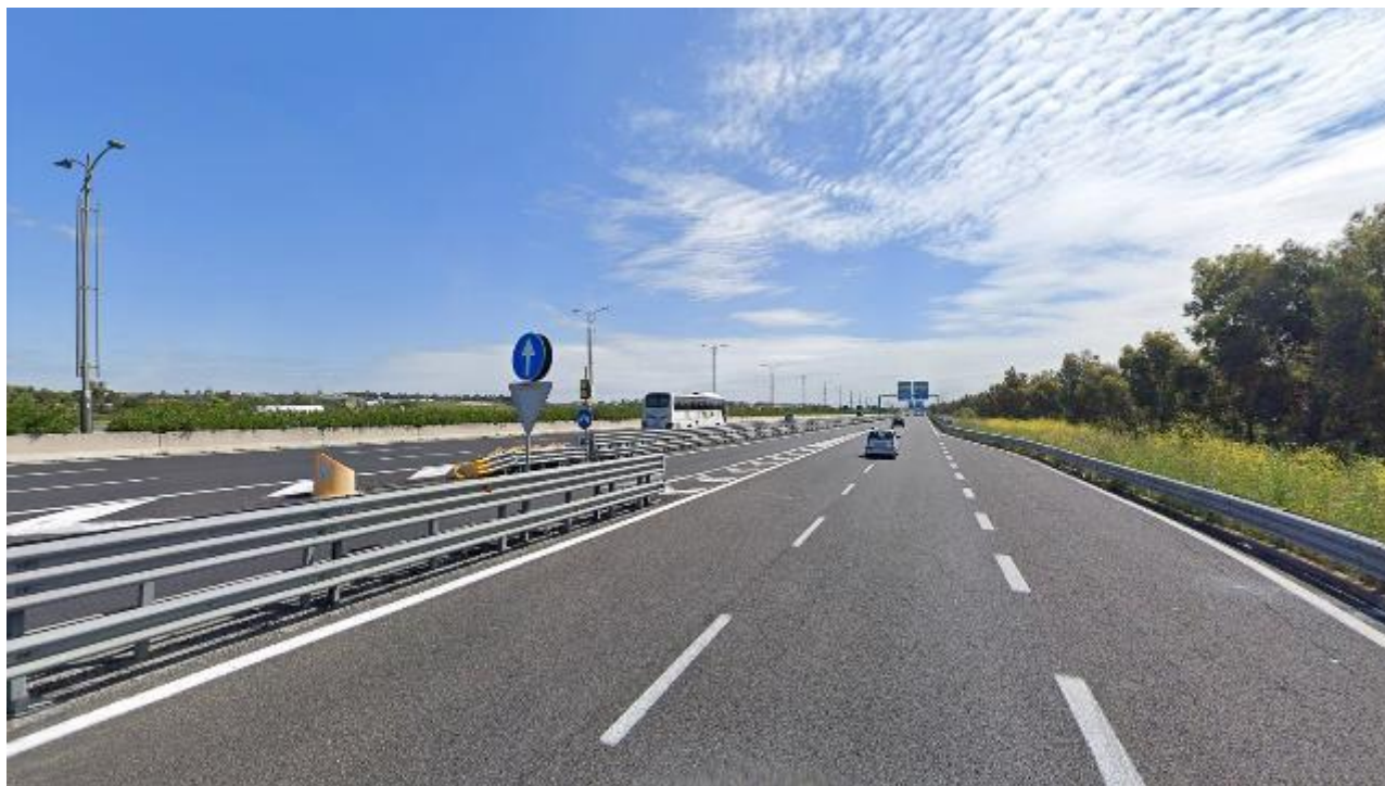
Figura 5-43 – Punto di vista dinamico n. 3 dalla corsia laterale verso Roma dell'Autostrada Roma Fiumicino e stato dei luoghi interessati
