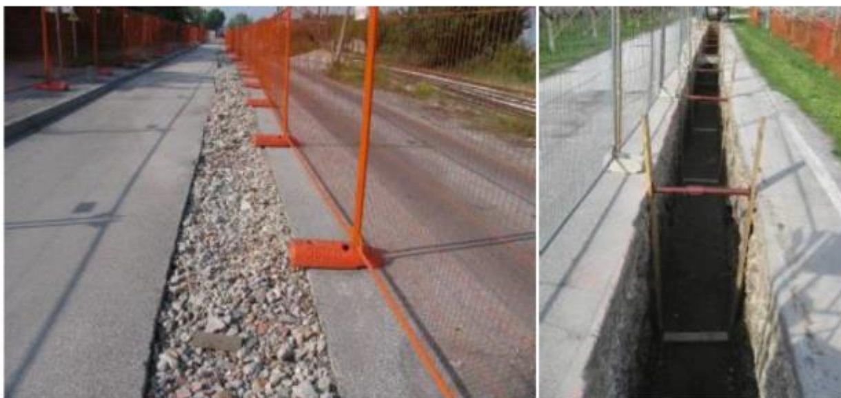
Figura 3-37- Esempio di posa a cielo aperto
