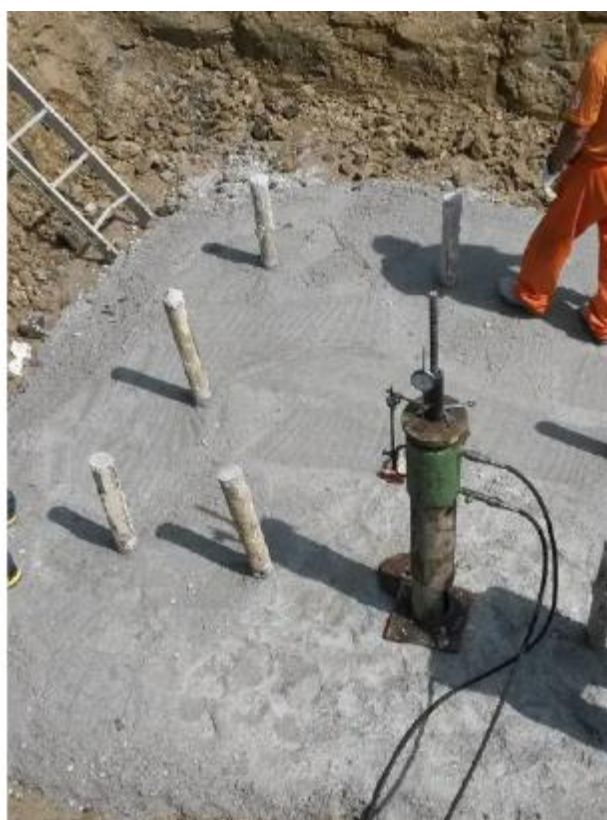
Figura 3-35 - Esempio realizzazione micropali per un sostegno a traliccio
