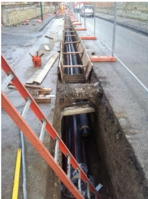
Figura 3-36- Esempio di posa in tubiera
