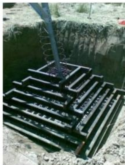
Figura 3-29- Esempio di realizzazione di una fondazione a plinto con riseghe. Nell'immagine di sinistra di può osservare un disegno di progetto mentre nell'immagine di destra la fase di casseratura della fondazione
