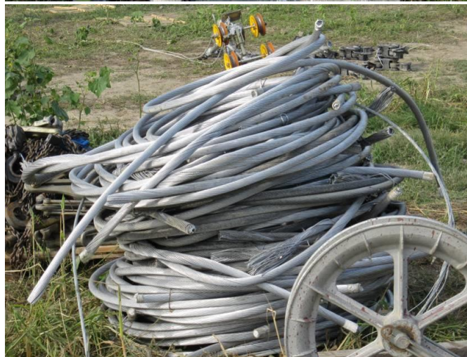
Figura 56 - Fasi demolizione di un sostegno a traliccio, particolare di materiale raccolto
