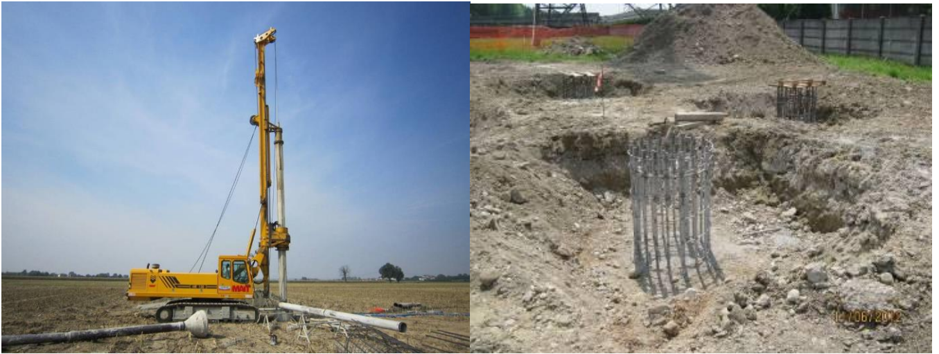
Figura 21 - Macchina operatrice per la realizzazione di pali trivellati
