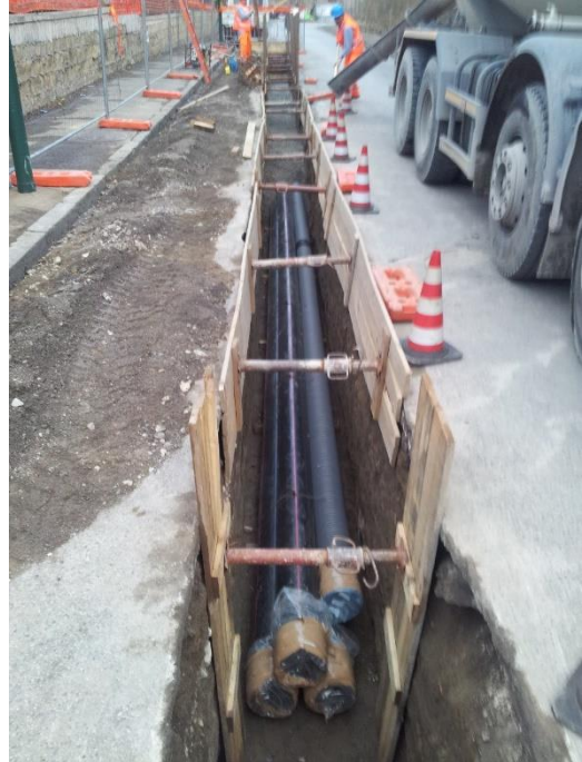
Figura 45 - Rinterro con posa delle tubiere
