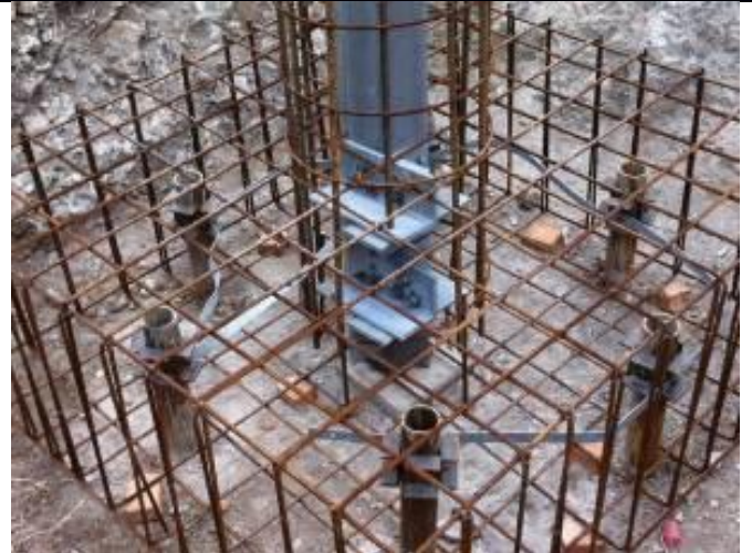
Figura 24 - Esempio di realizzazione di una fondazione su micropali tipo tubfix. Nell'immagine di destra si può notare il particolare del raccordo tra i tubolari metallici dei micropali con l'armatura del plinto di fondazione; al centro del plinto si nota il moncone del sostegno (elemento di raccordo tra il sostegno e la fondazione) il quale viene annegato nella fondazione stessa
