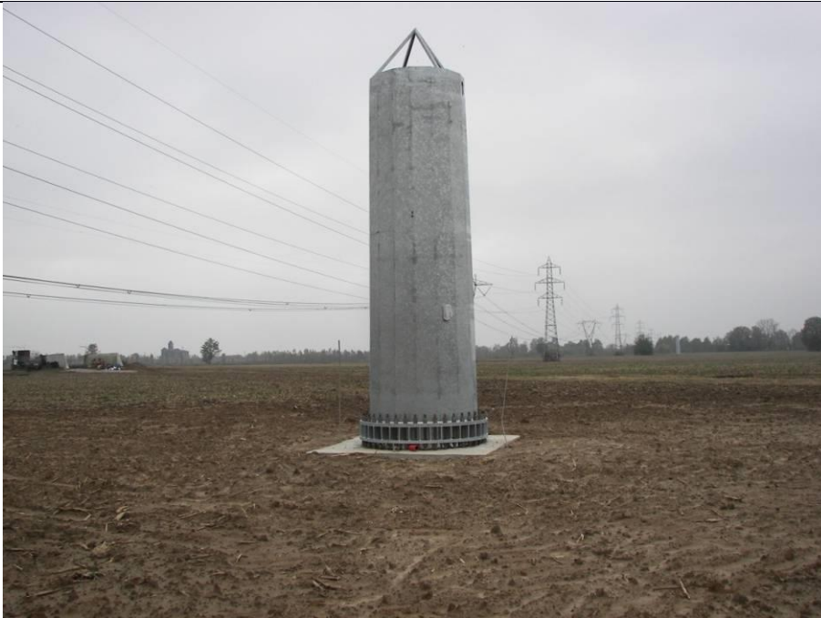
Figura 18 - Realizzazione di fondazioni superficiali tipo plinto a monoblocco per un sostegno monostelo. Nell'immagine è riportato un esempio di fondazione completata e la sistemazione del terreno nell'area circostante.
