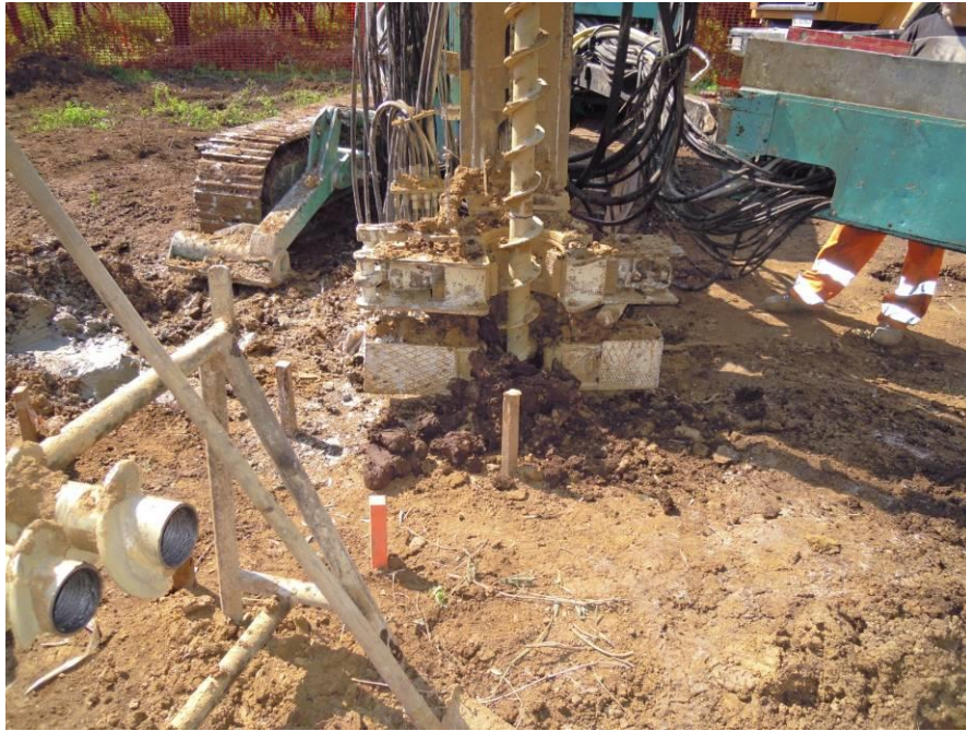
Figura 26 - Macchina operatrice per la realizzazione di micropali tubfix; sistema di scavo mediante trivella elicoidale
