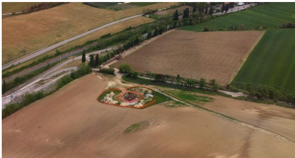
Figura 9 - Area Sostegno veduta dall'alto dell'estensione complessiva del micro-cantiere
