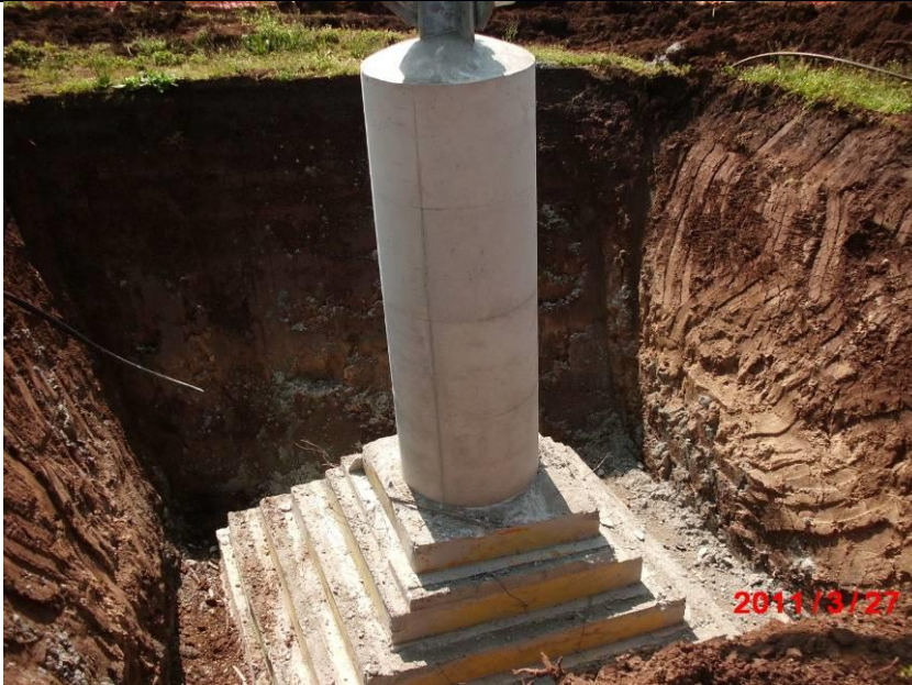
Figura 13 - Realizzazione di fondazioni superficiali tipo CR per un sostegno a traliccio. Nell'immagine si può osservare una fondazione CR appena "scasserata". Si possono distinguere facilmente la parte inferiore a parallelepipedi tronco piramidali ed il colonnino di raccordo con la "base" del sostegno
