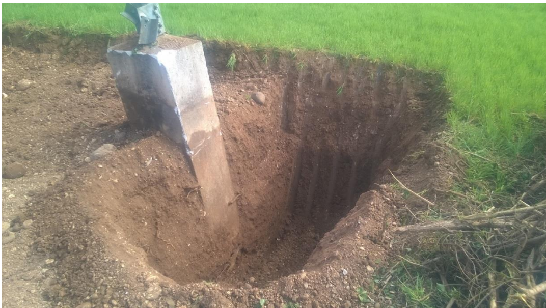
Figura 58 - Esempio rimozione della fondazione superficiale di un sostegno 380 kV ST
