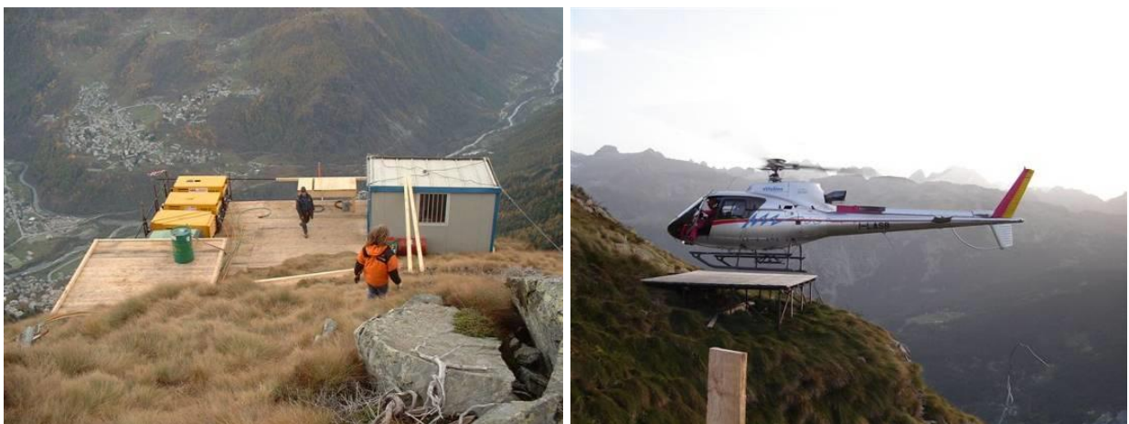
Figura 30 - Esempi di micro - cantieri in quota
