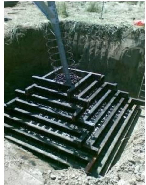
Figura 11 - Esempio di realizzazione di una fondazione a plinto con riseghe. Nell'immagine di sinistra di può osservare un disegno di progetto mentre nell'immagine di destra la fase di casseratura della fondazione
