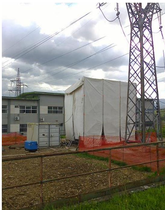
Figura 52- esempio ponteggio per esecuzione terminali
