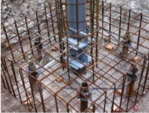
Figura 3-16- Esempio realizzazione micropali
