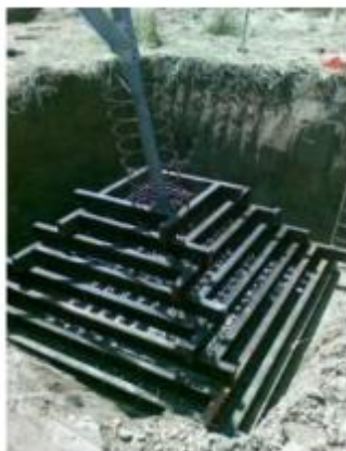
Figura 3-13- Fondazione a plinto con riseghe.
