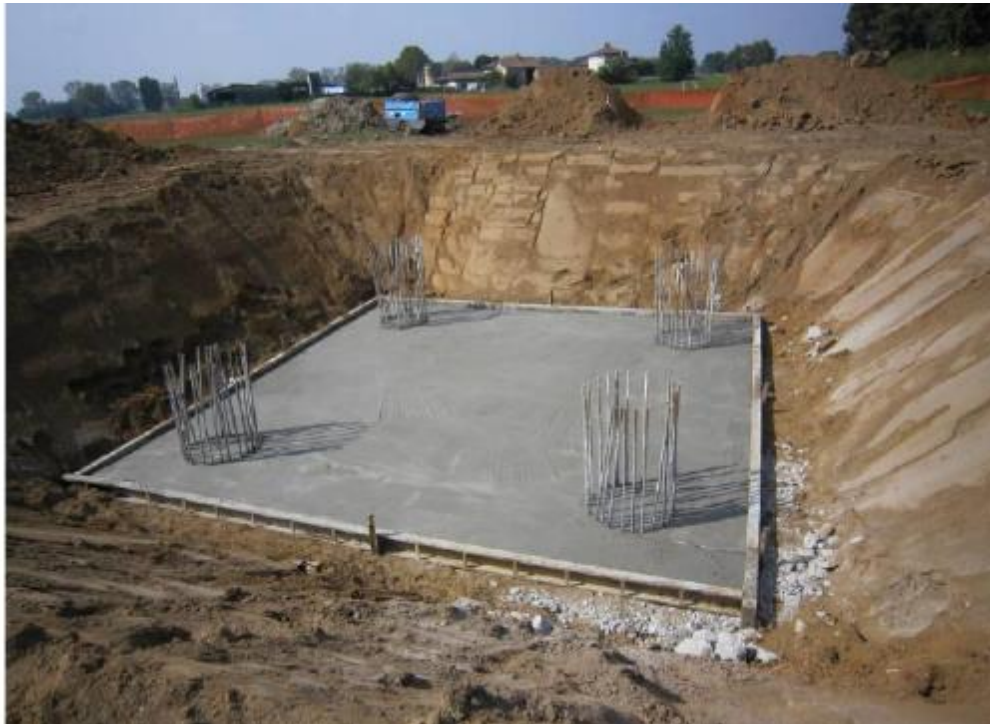
Figura 3-15- Realizzazione di una fondazione su pali trivellati per un sostegno monostelo
