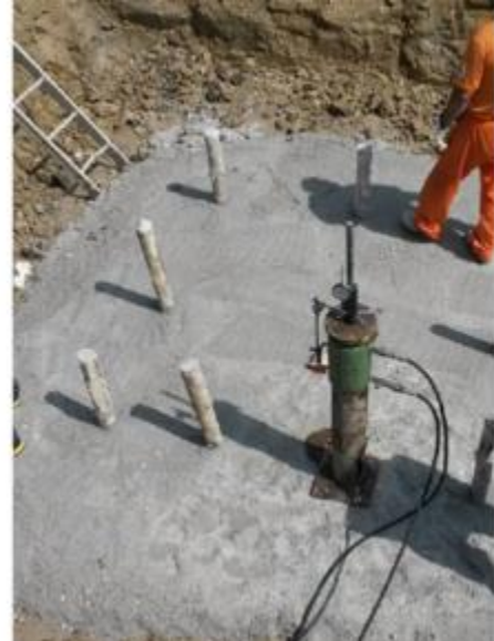
Figura 3-17- Esempio realizzazione micropali per un sostegno a traliccio
