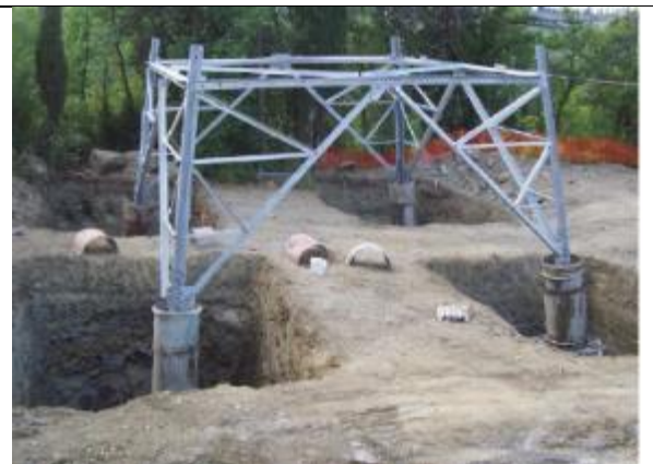
Figura 3-14- Fondazione tramite "monconi" e casseri utilizzati per i quattro "colonnini"
