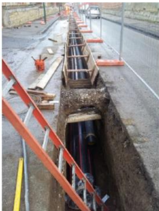
Figura 3-18- Esempio di posa in tubiera
