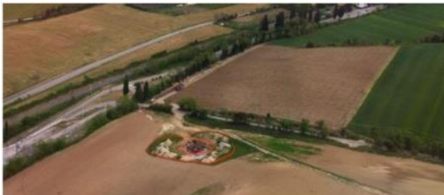
Figura 3-12- Area Sostegno veduta dall'alto dell'estensione complessiva del micro-cantiere
