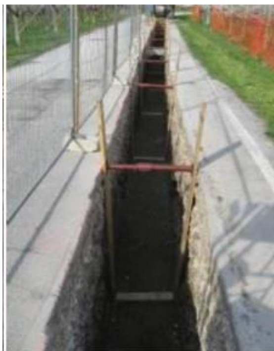
Figura 3-19- Esempio di posa a cielo aperto
