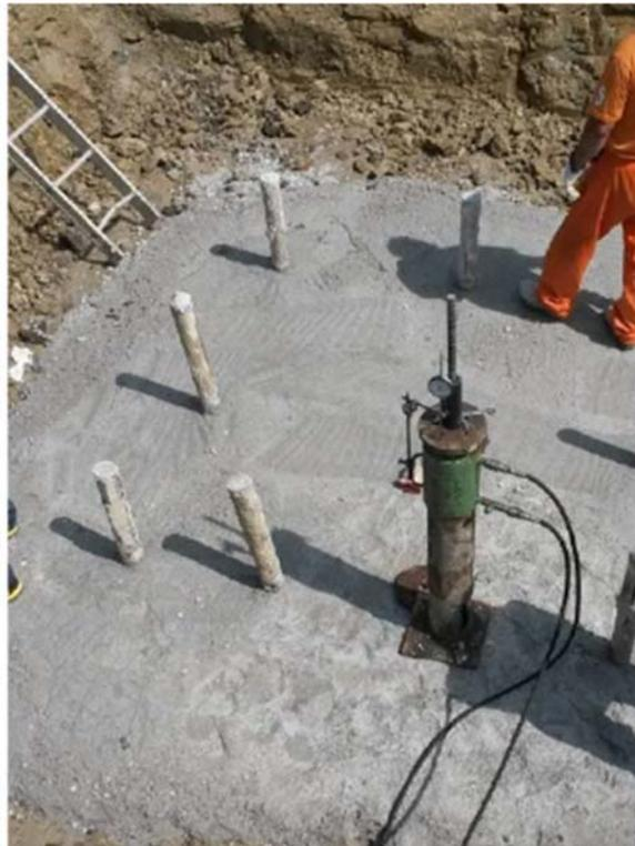
**Figura 3.10-9 - Esempio realizzazione micropali per un sostegno a traliccio**
