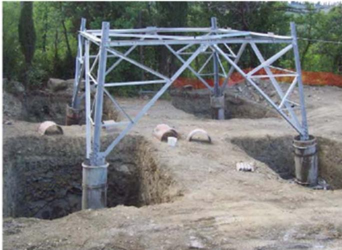
**Figura 3.10-4- Nell'immagine si possono osservare le quattro buche, la base del sostegno collegata alla fondazione tramite i "monconi" ed i casseri utilizzati per i quattro "colonnini"**
