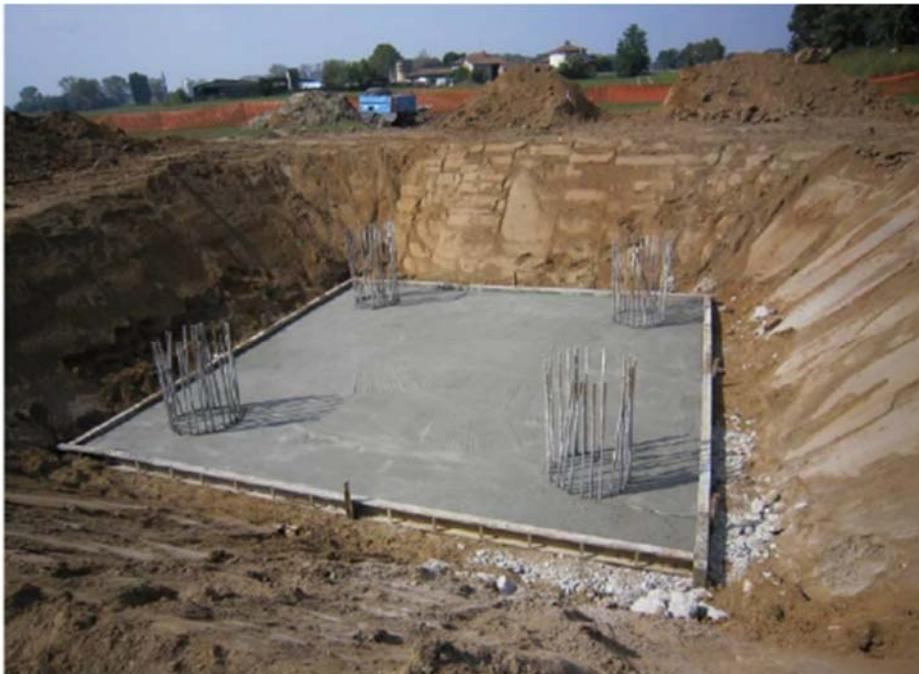
**Figura 3.10-6- Realizzazione di una fondazione su pali trivellati per un sostegno monostelo**
