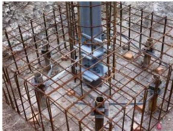
**Figura 3.10-8- Esempio realizzazione micropali**
