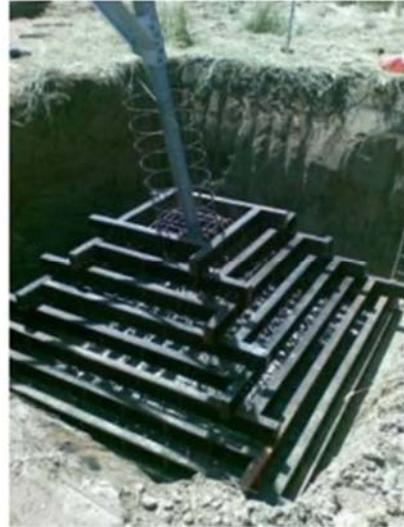
**Figura 3.10-3- Esempio di realizzazione di una fondazione a plinto con riseghe. Nell'immagine di sinistra di può osservare un disegno di progetto mentre nell'immagine di destra la fase di casseratura della fondazione**
