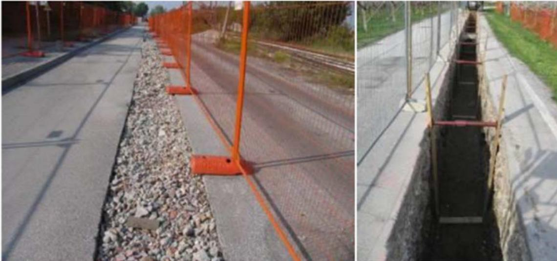
**Figura 3.10-11- Esempio di posa a cielo aperto**
