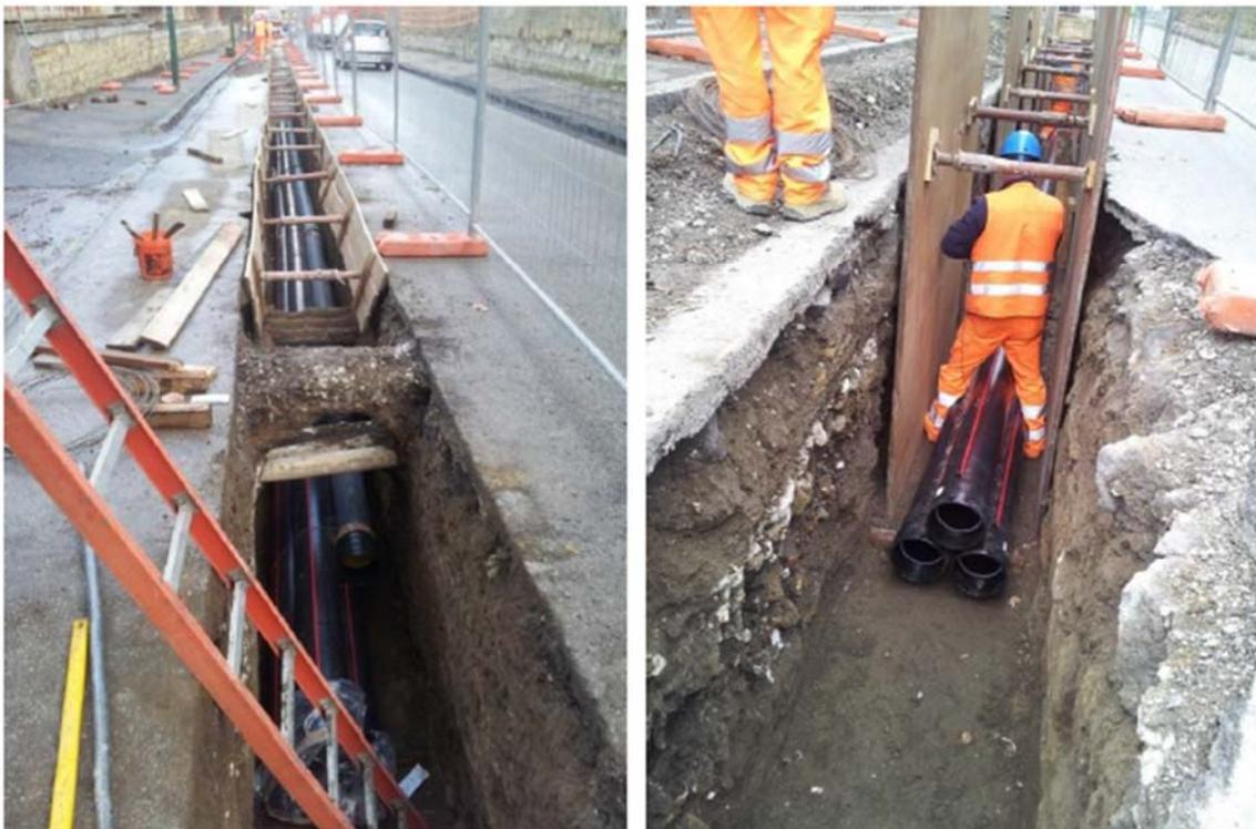
**Figura 3.10-10- Esempio di posa in tubiera**
