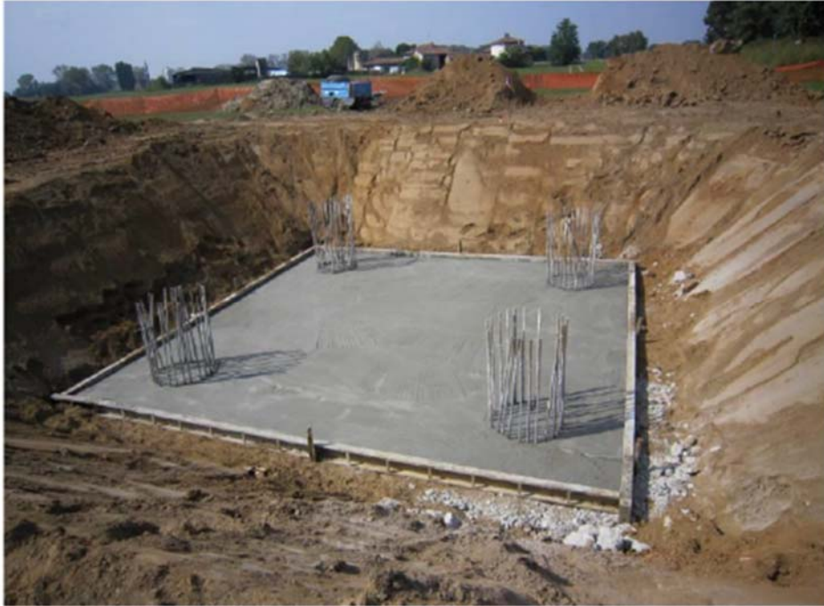
Figura 2-12- Realizzazione di una fondazione su pali trivellati per un sostegno monostelo
