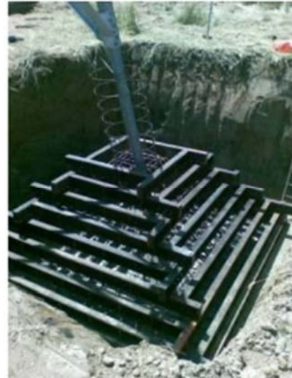
Figura 2-9- Esempio di realizzazione di una fondazione a plinto con riseghe. Nell'immagine di sinistra di può osservare un disegno di progetto mentre nell'immagine di destra la fase di cassatura della fondazione
