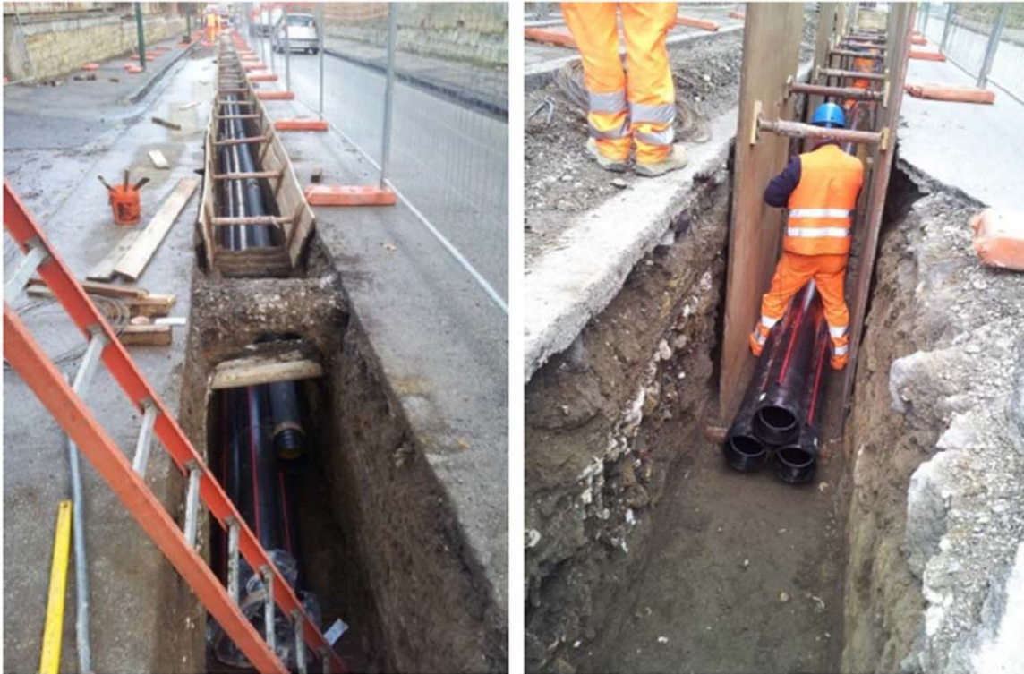
Figura 2-16- Esempio di posa in tubiera
