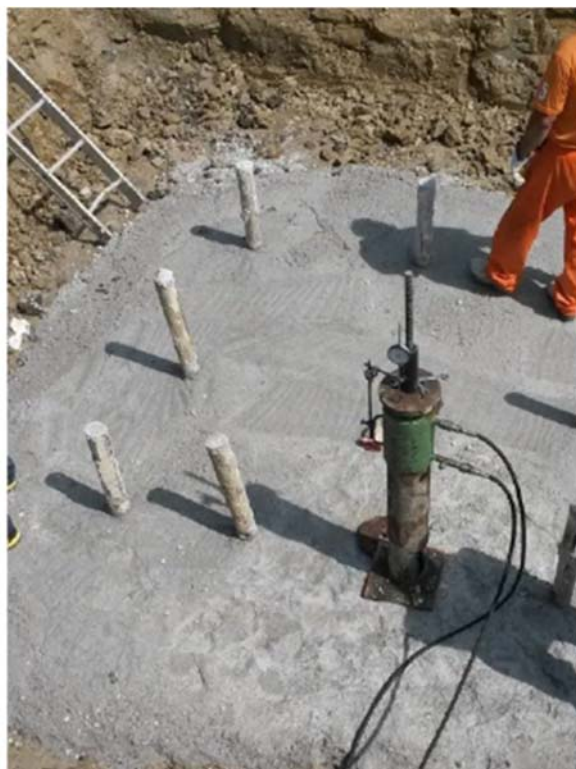
Figura 2-15 - Esempio realizzazione micropali per un sostegno a traliccio
