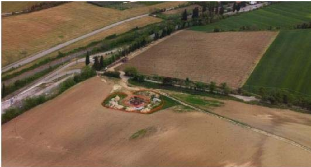
Figura 2-8- Area Sostegno veduta dall'alto dell'estensione complessiva del micro-cantiere
