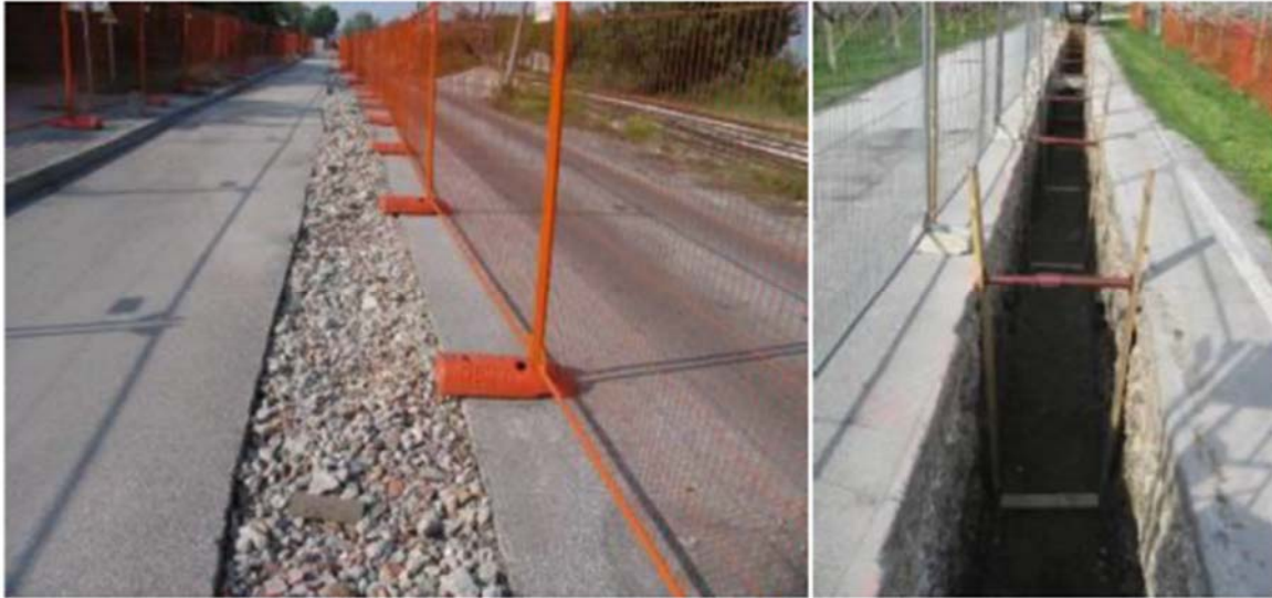
Figura 2-17- Esempio di posa a cielo aperto
