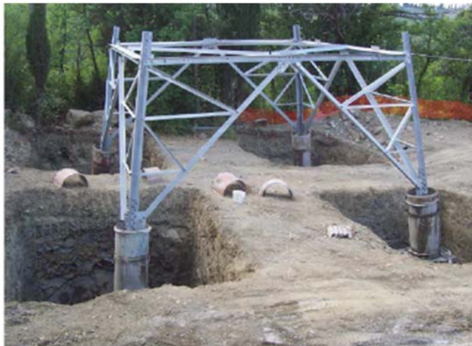
Figura 2-10- Nell'immagine si possono osservare le quattro buche, la base del sostegno collegata alla fondazione tramite i "monconi" ed i casseri utilizzati per i quattro "colonnini"
