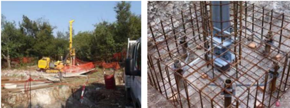
Figura 3-13- Esempio realizzazione micropali
