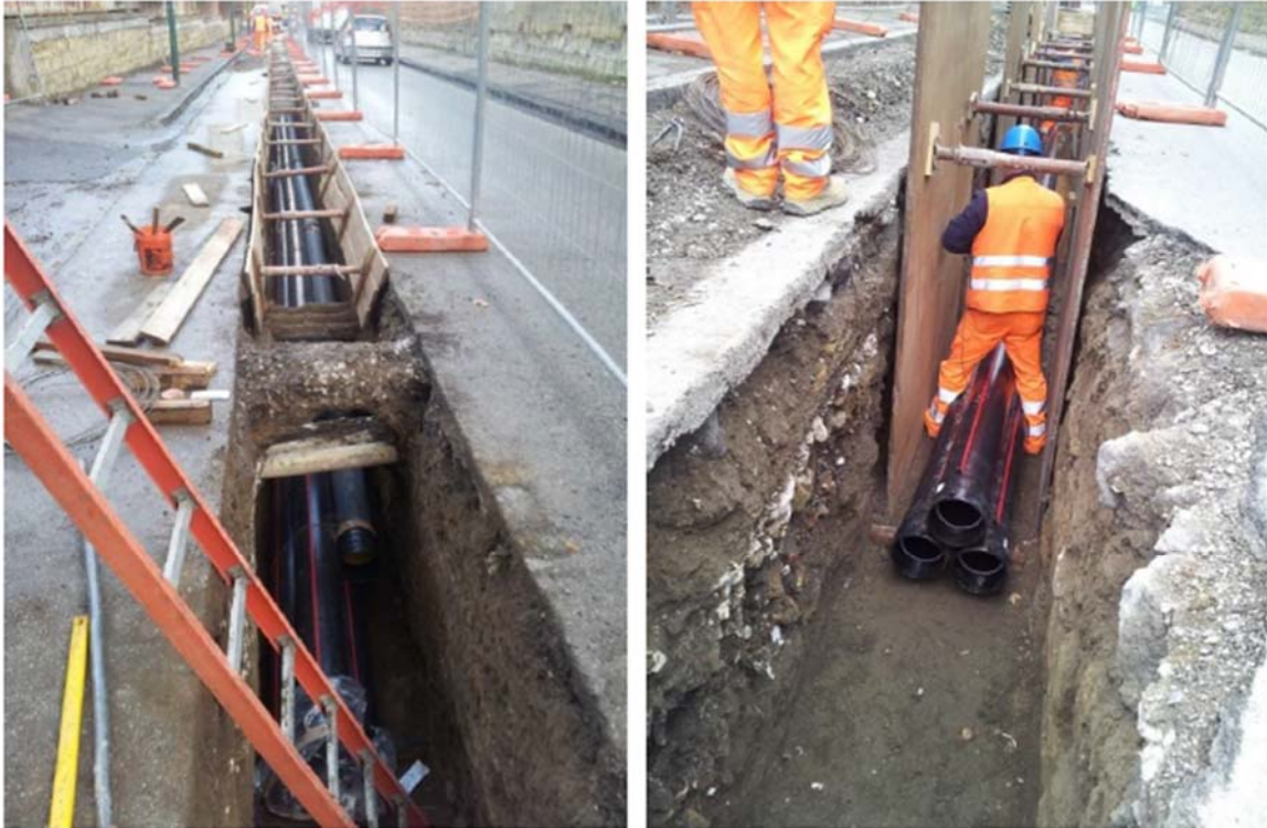
Figura 3-15- Esempio di posa in tubiera
