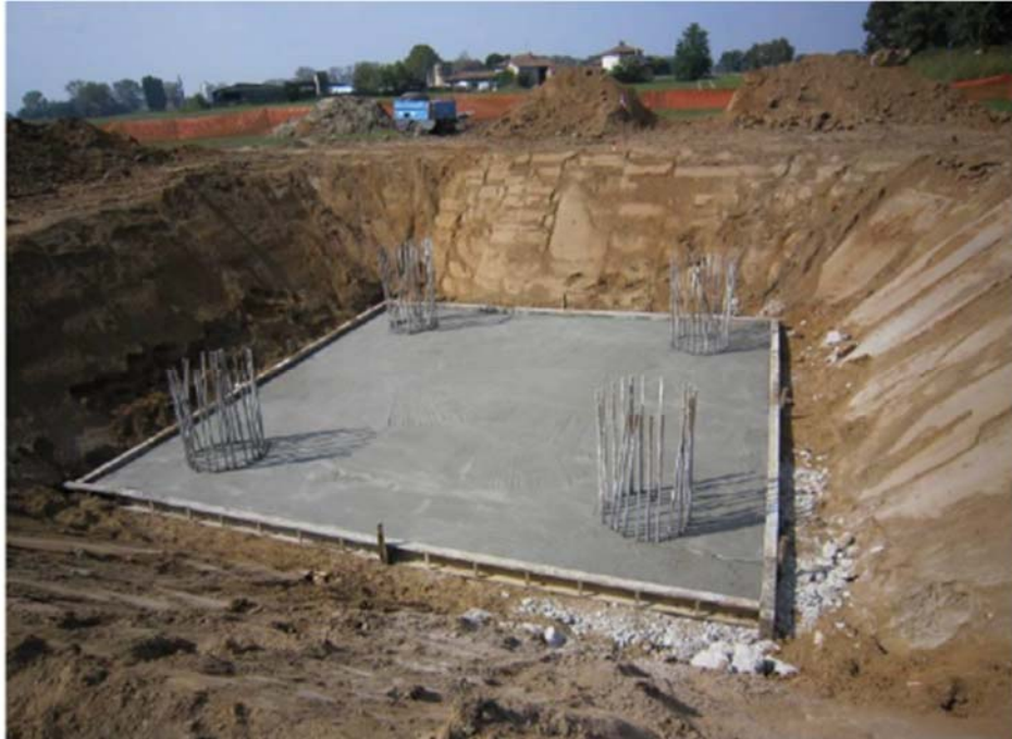
Figura 3-11- Realizzazione di una fondazione su pali trivellati per un sostegno monostelo
