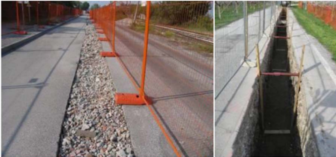
Figura 3-16- Esempio di posa a cielo aperto
