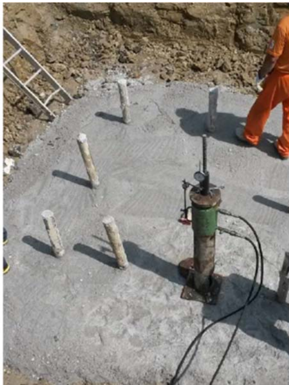
Figura 3-14 - Esempio realizzazione micropali per un sostegno a traliccio
