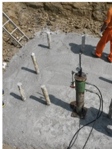
Figura 4-9 - Esempio realizzazione micropali per un sostegno a traliccio
