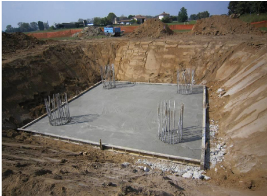
Figura 4-8- Realizzazione di una fondazione su pali trivellati
