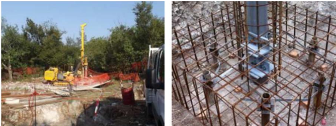
Figura 5-8- Esempio realizzazione micropali
