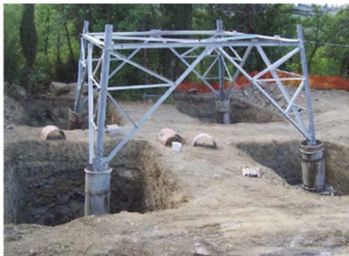
Figura 5-4- Nell'immagine si possono osservare le quattro buche, la base del sostegno collegata alla fondazione tramite i "monconi" ed i casseri utilizzati per i quattro "colonnini"
