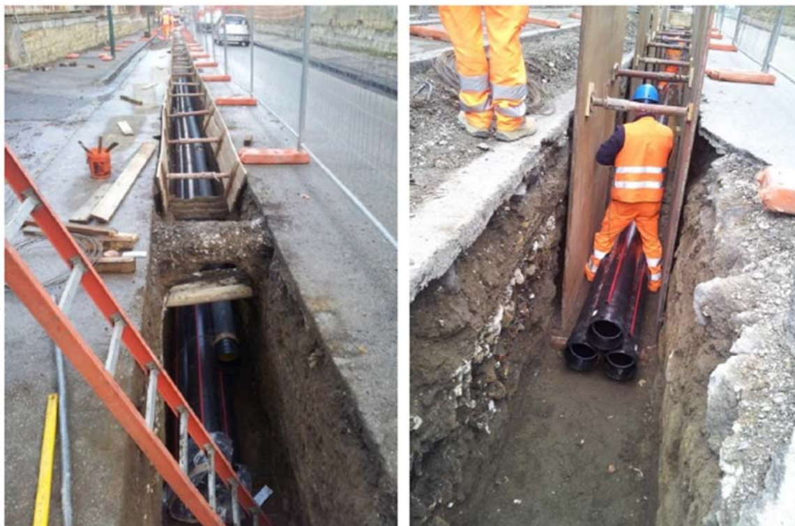
Figura 5-10- Esempio di posa in tubiera
