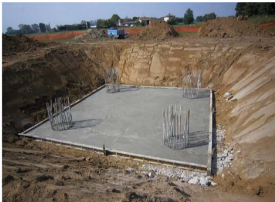
Figura 5-6- Realizzazione di una fondazione su pali trivellati per un sostegno monostelo
