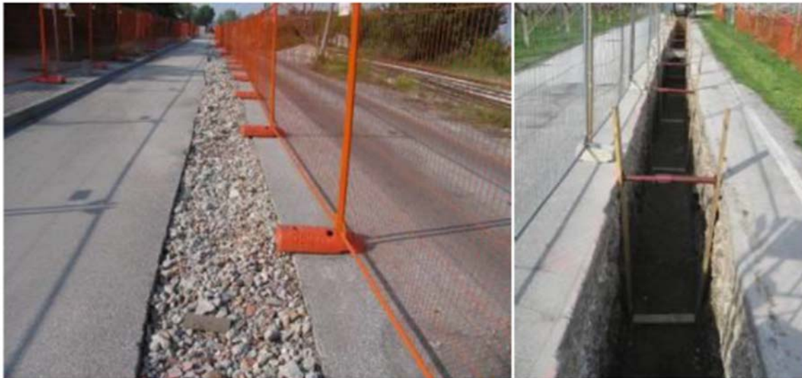
Figura 5-11- Esempio di posa a cielo aperto
