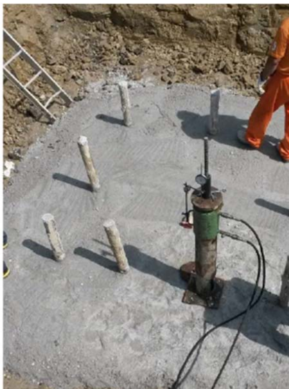
Figura 5-9 - Esempio realizzazione micropali per un sostegno a traliccio
