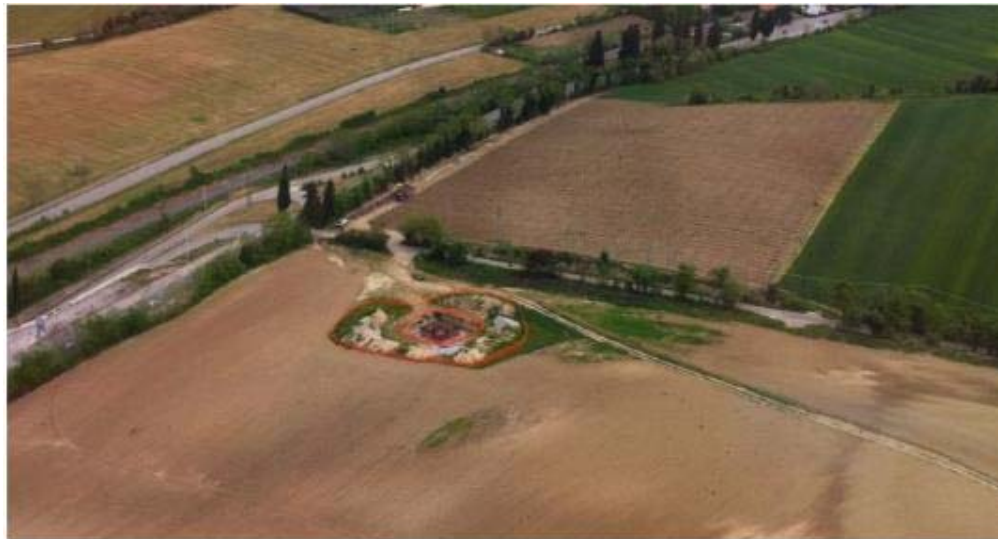
Figura 5-2- Area Sostegno veduta dall'alto dell'estensione complessiva del micro-cantiere
