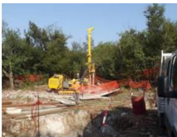
Esempio realizzazione micropali
