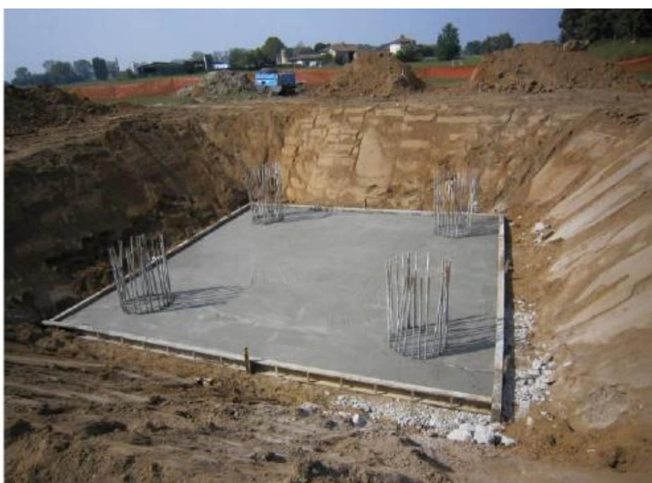
Realizzazione di una fondazione su pali trivellati
