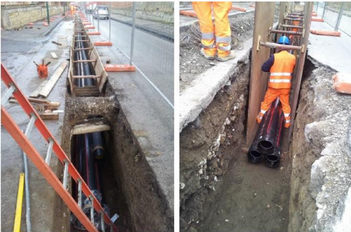
Esempio di posa in tubiera
