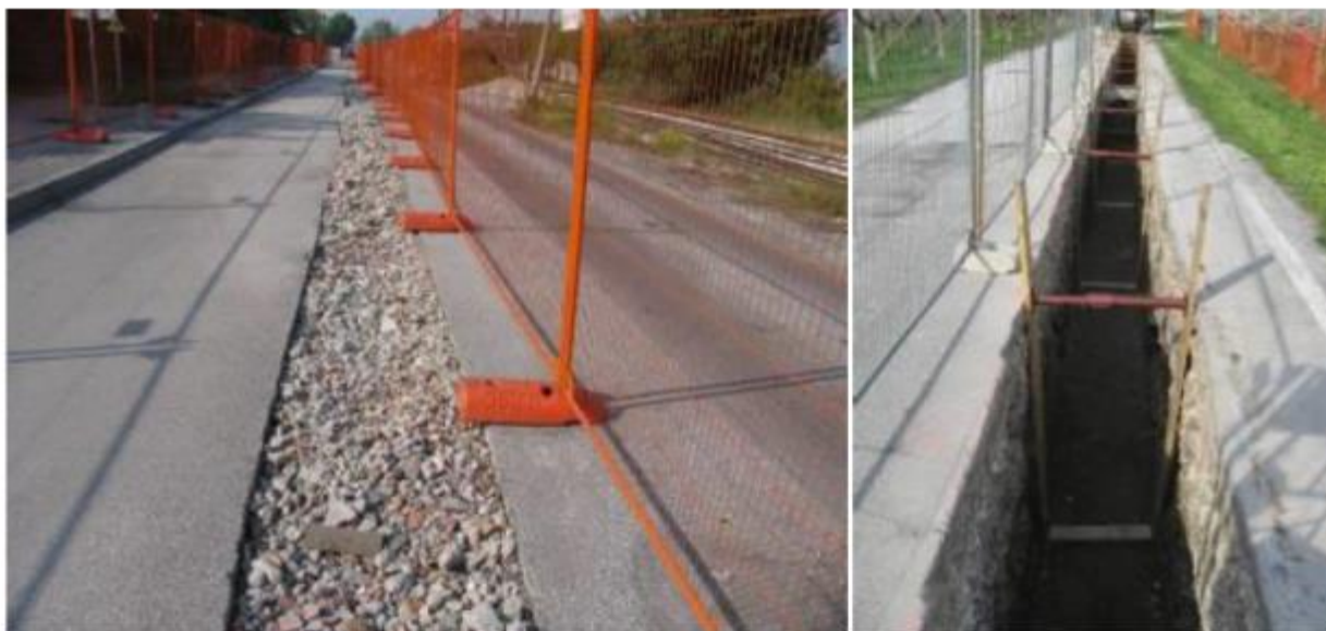
Esempio di posa a cielo aperto
