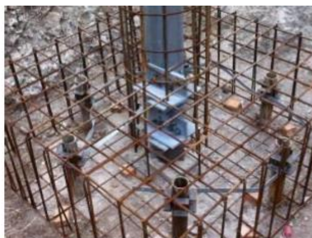
Esempio realizzazione micropali
