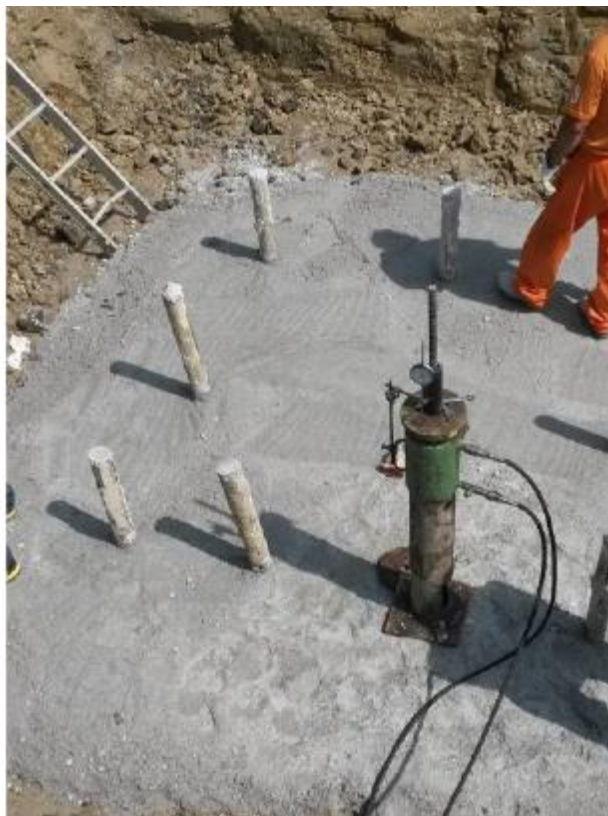
Esempio realizzazione micropali per un sostegno a traliccio
