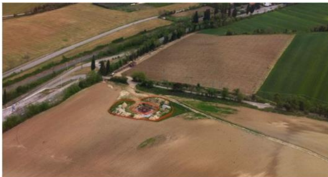
Area Sostegno veduta dall'alto dell'estensione complessiva del micro-cantiere
