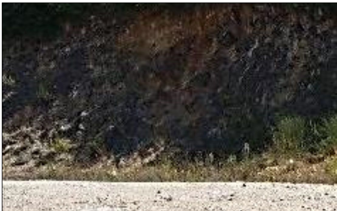
Figura 4-3 - Affioramento del Calcere cavernoso (CV) in corrispondenza del taglio eseguito per la realizzazione di un piazzale prossimo alla Pk. 45+700 circa.
