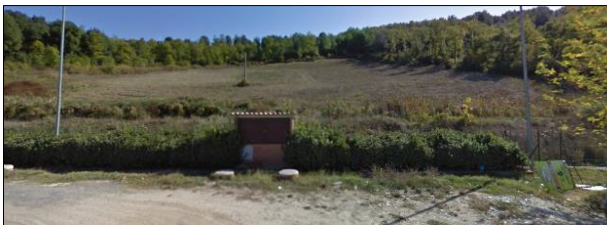
Figura 3-3 - Ripresa panoramica frontale del cumulo di frana antica (ottobre 2019).
