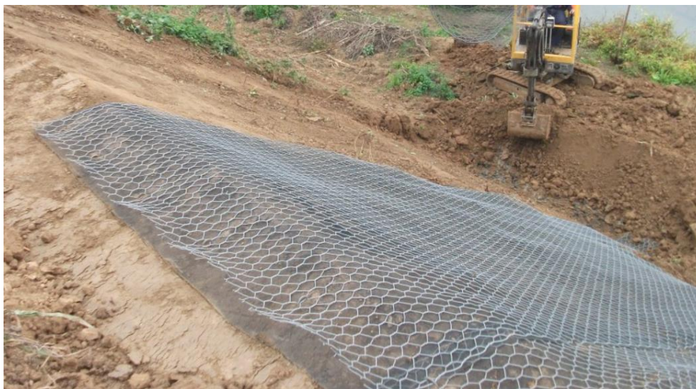
Figura 5-11 - Rivestimento del rilevato con rete antinutria.
