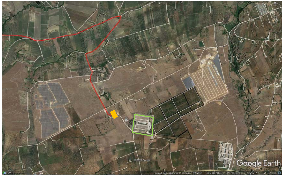
Riquadro R3: tracciato del nuovo elettrodotto in MT, si può osservare che vengono certamente interessate viabilità esistenti. In arancione l'ingombro della nuova SSEU, la linea in verde indica il perimetro della esistente Stazione Elettrica Partanna
