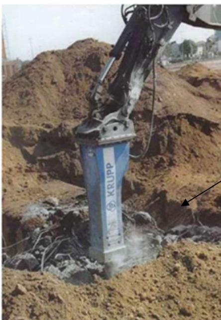
Operazione di demolizione di opera in cemento armato con martellone idraulico.
