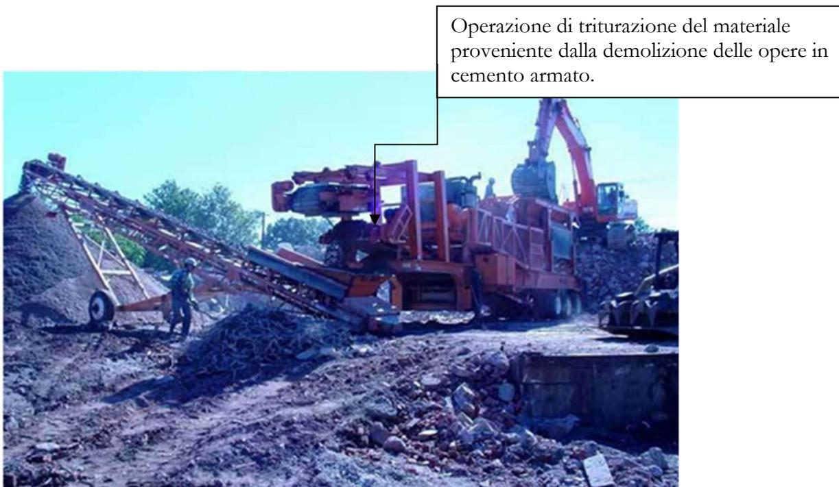
Figure 24: Particolari demolizione fondazioni o opere in C.A.
