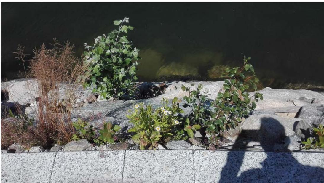
*Figura 62: Dettaglio della nuova scogliera in fase di colonizzazione di vegetazione igrofila.*
