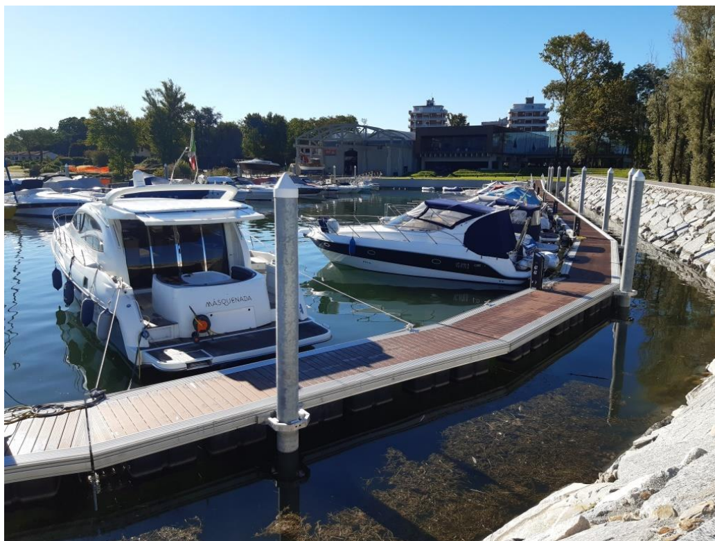
Figura 14: nuovi pontili galleggianti posati
