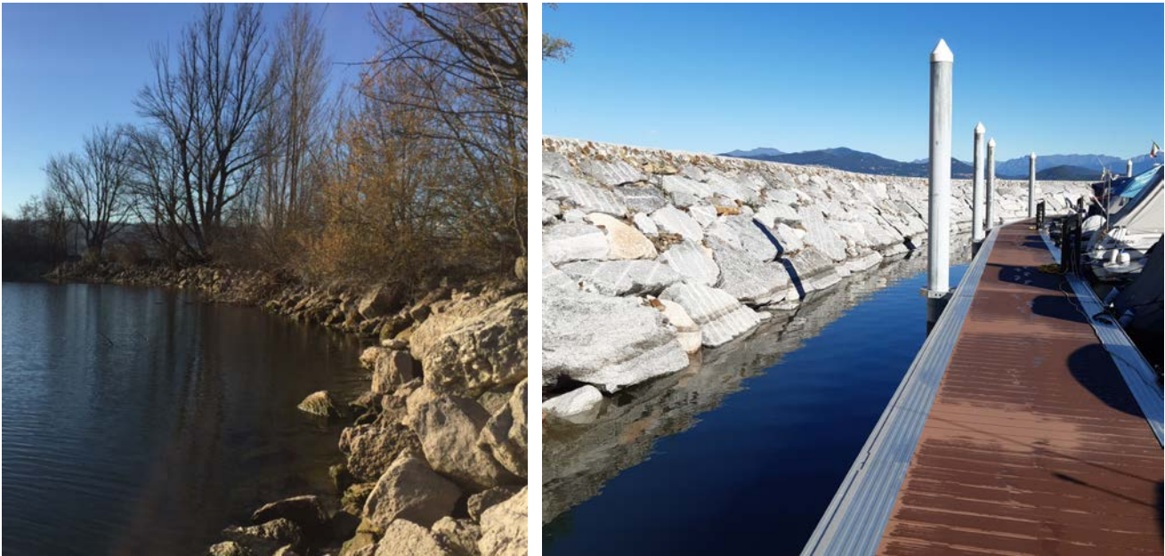
Figura 12: massi utilizzati per la scogliera (a sinistra la scogliera pregressa a destra la scogliera dopo gli interventi)
