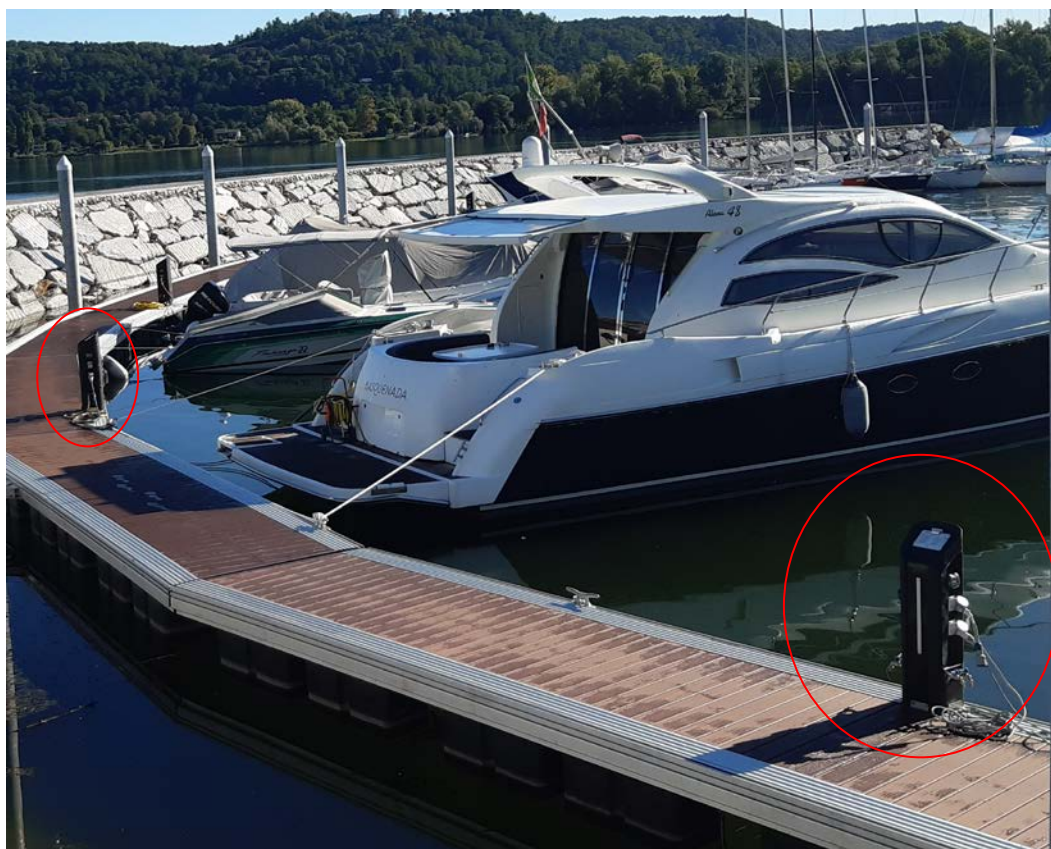
Figura 16: colonnine erogazione servizi
