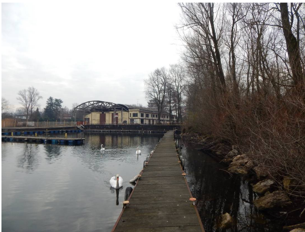
Figura 11: pontili galleggianti pre-esistenti
