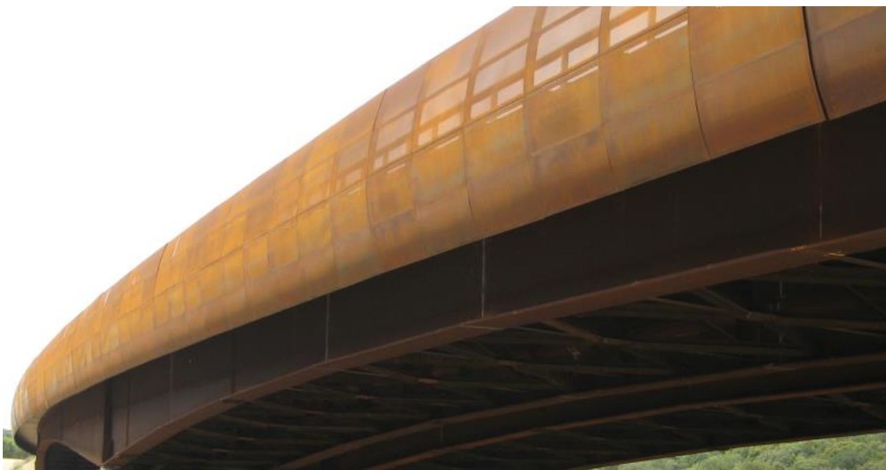
Figura 22: Esempio di carter in lamiera corten microforata
