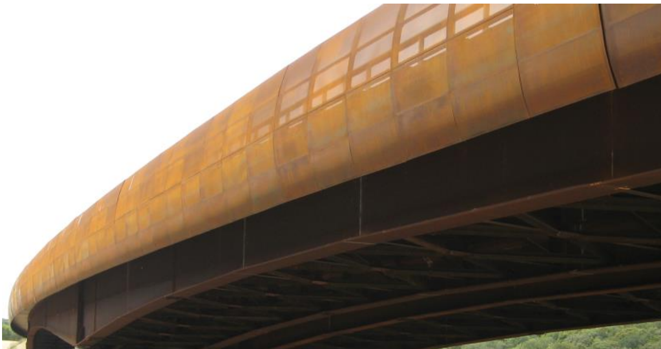
Figura 30: Esempio di carter in lamiera corten microforata
