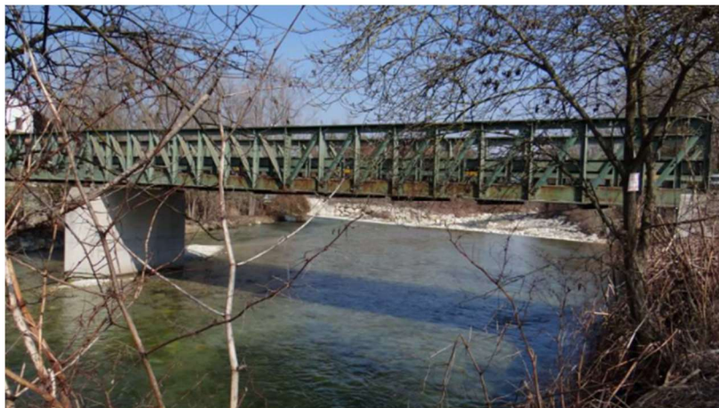
Figura 9 –Traversa di derivazione a monte dell'impalcato di progetto e ponte stradale esistente.
