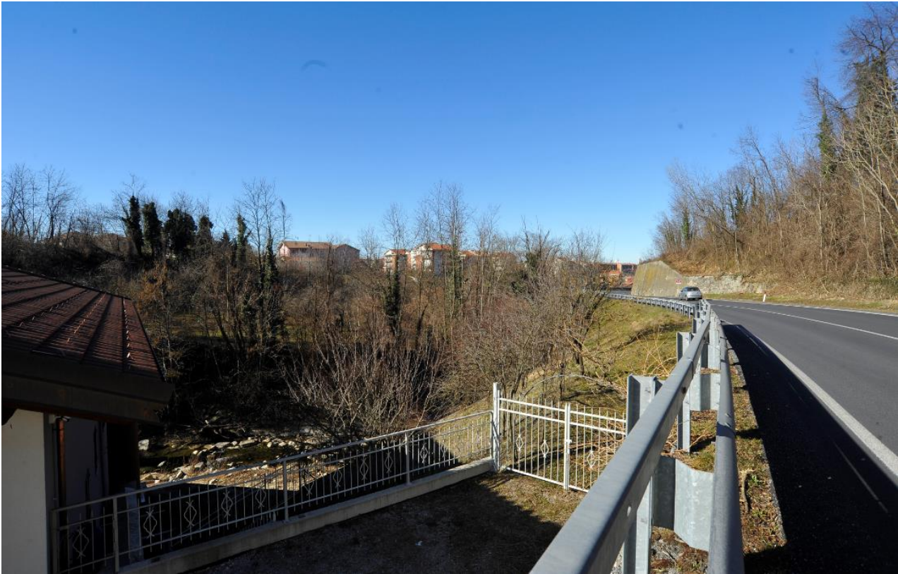
Vista da SP 28 Nord - Ante operam.
