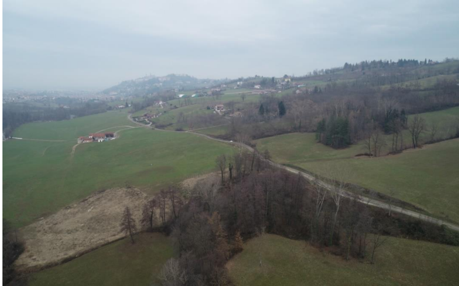
Figura 3.11 Area di imbocco della galleria naturale: versanti medio – collinari coltivati
