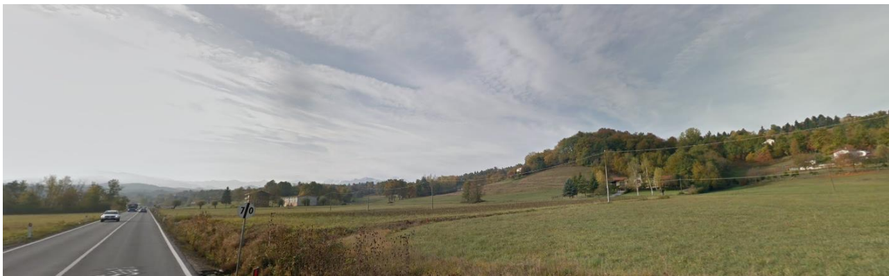
Figura 7.3 - Rotatoria di connessione con la SS28 ed imbocco della galleria S Lorenzo: intervisibilità relativ alle zone immediatamente adiacenti l'area di intervento
