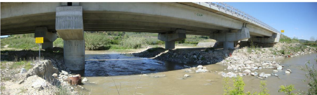
Il viadotto Mesima 4
