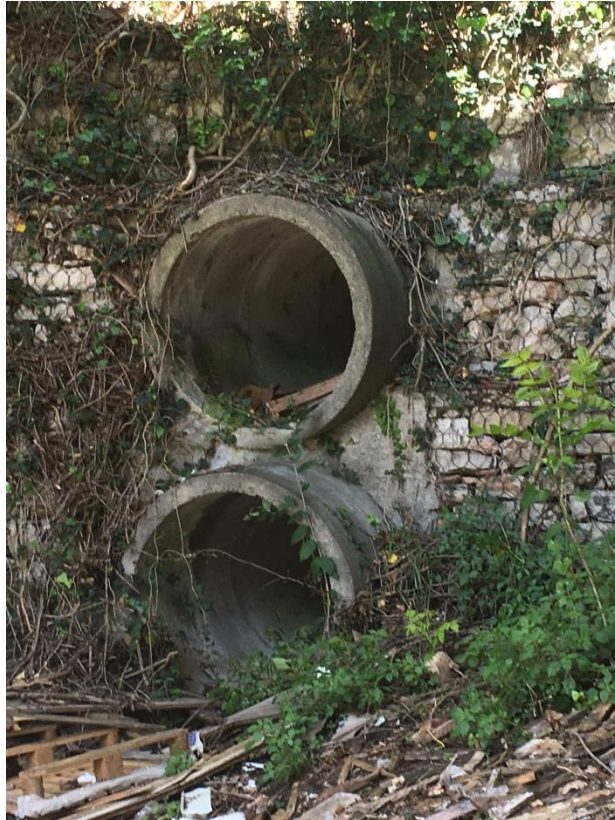
Figura 2-2 – sbocco tombamento esistente del Fosso Valle della Torre
