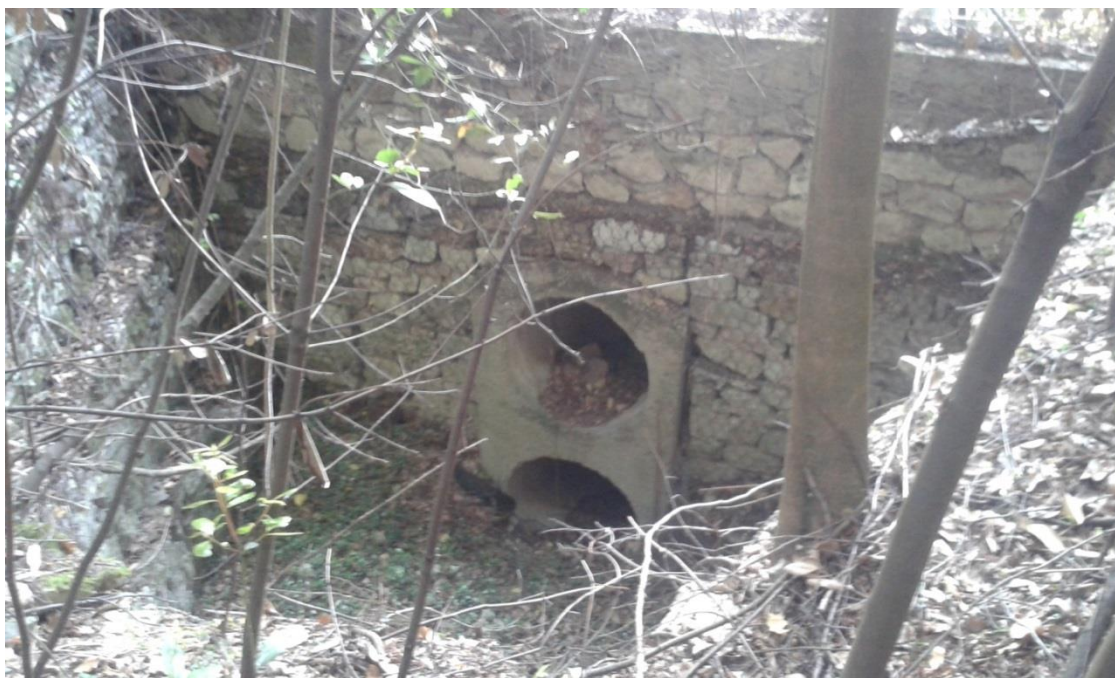
Figura 2-1 – imbocco tombamento esistente del Fosso Valle della Torre
