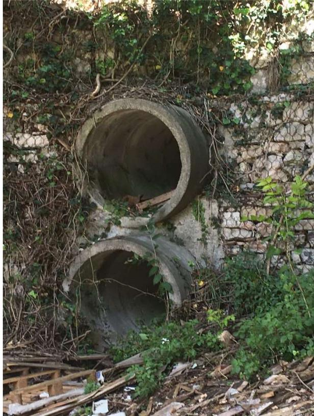
Figura 2-3 – sbocco tombamento esistente del Fosso Valle della Torre
