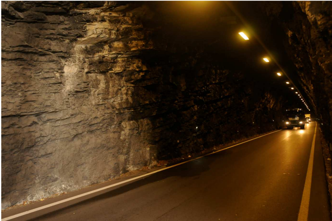
Fig. 5 – Dettaglio parete a "roccia viva"
