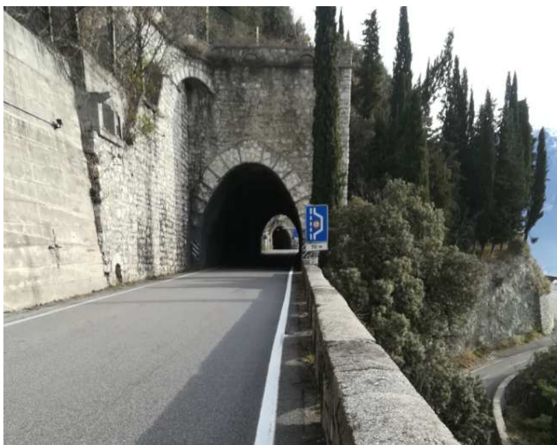
Fig. 2 – Dettaglio gallerie ogivali
