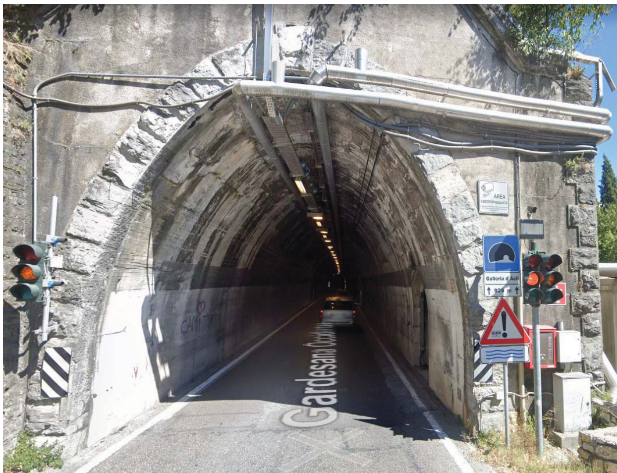
Figura 6 – D'Acili imbocco Sud
