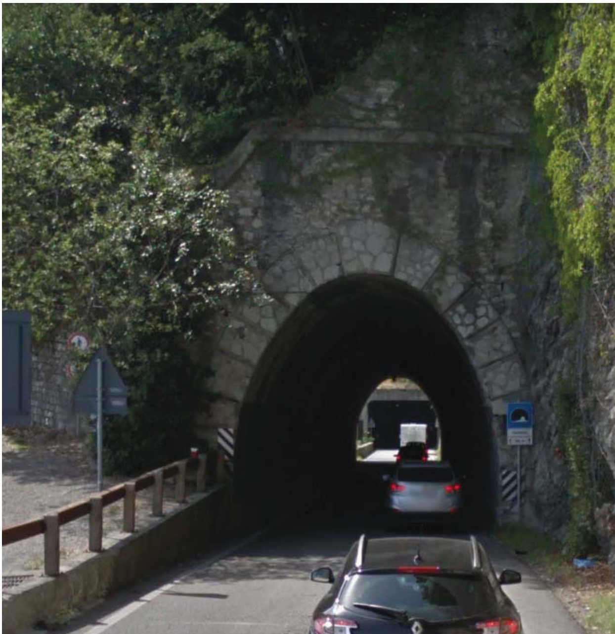
Figura 11 – D'Acili imbocco Nord
