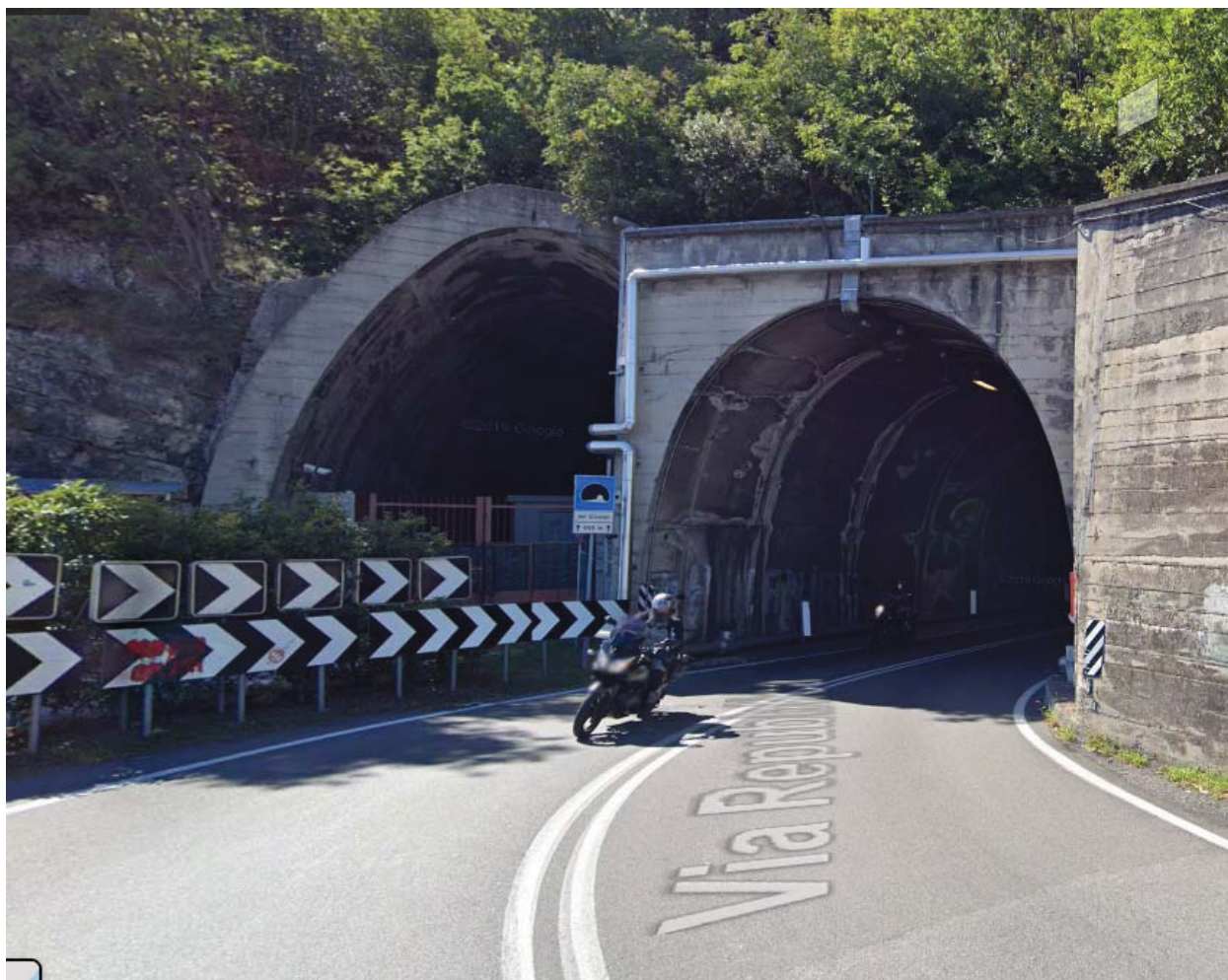
Figura 19 – Dei Ciclopi imbocco Nord
