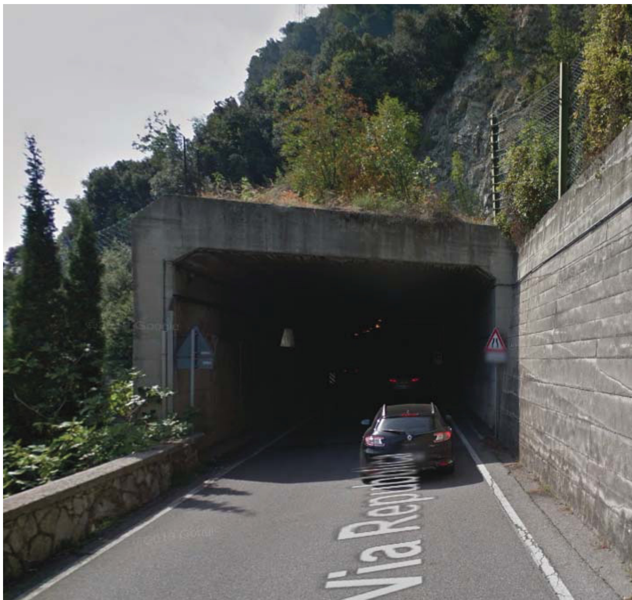
Figura 7 – D'Acili imbocco Nord
