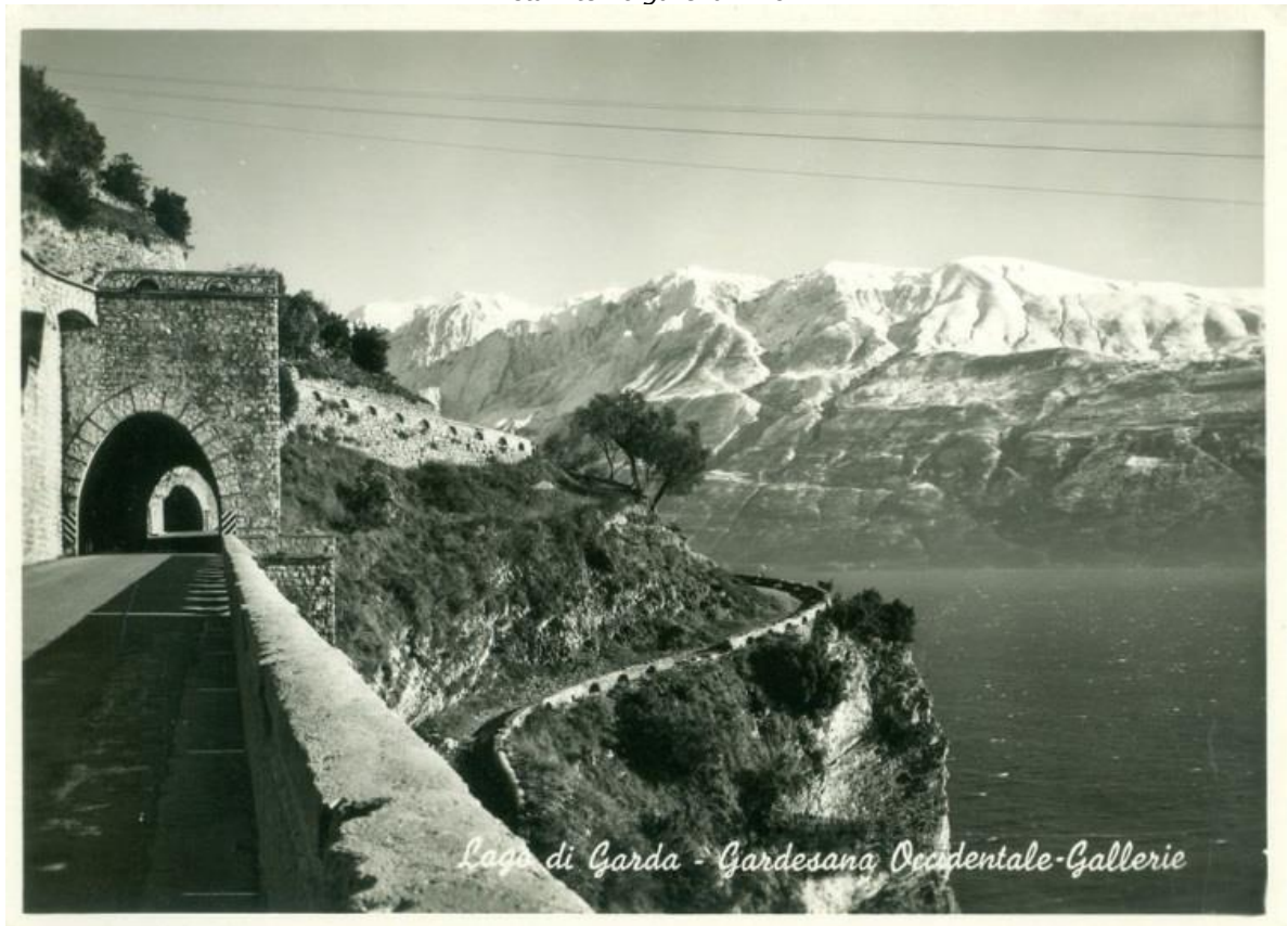
Vista imbocco sud galleria Eutemia. Sulla destra è visibile la strada Panoramica
