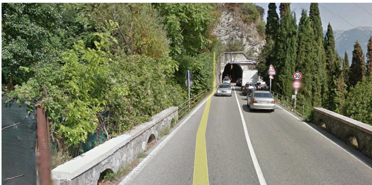
Vista imbocco sud galleria D'Acli
