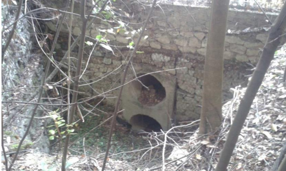
Figura 2-73 Imbocco tombamento esistente del Fosso Valle della Torre
