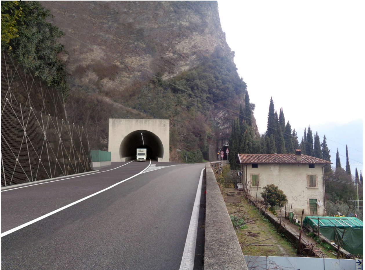
Figura 6-7- Post operam punto di vista 2
