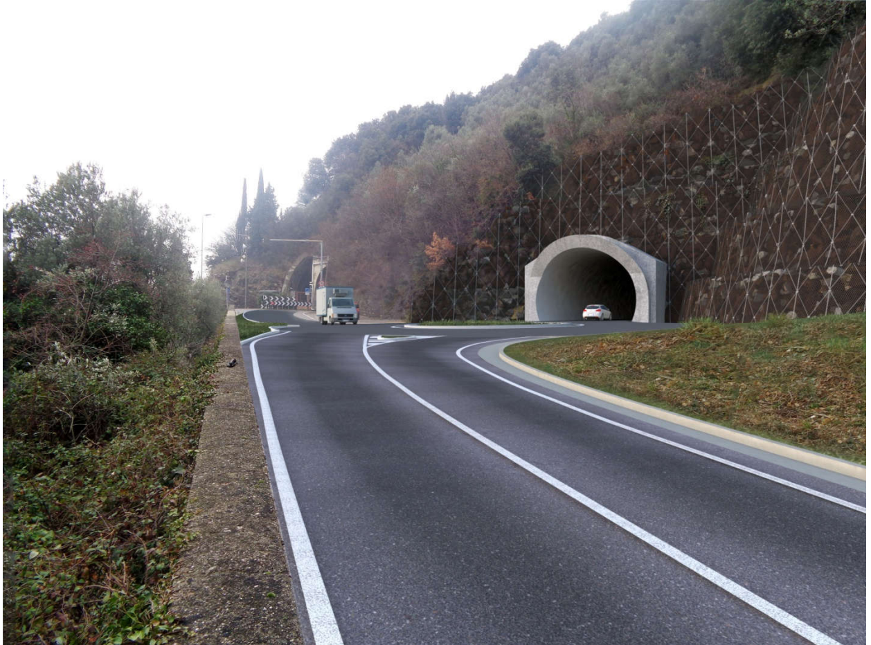
Figura 6-4 - Post operam punto di vista 1
