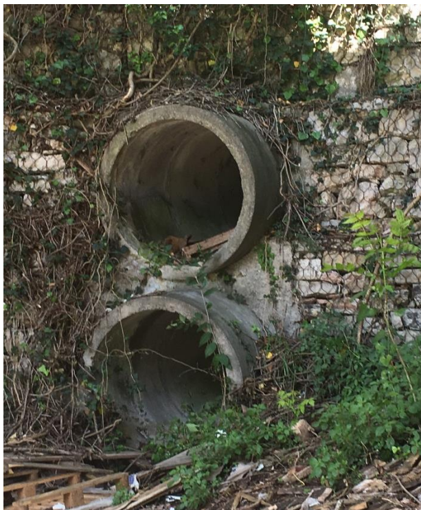
Figura 8.2 – Sbocco tombamento esistente del Fosso Valle della Torre.
