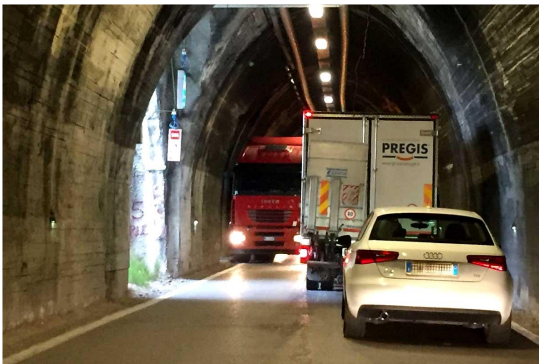
Figura 1.3 – Ingorgo galleria D'Acli in tratto rivestito
