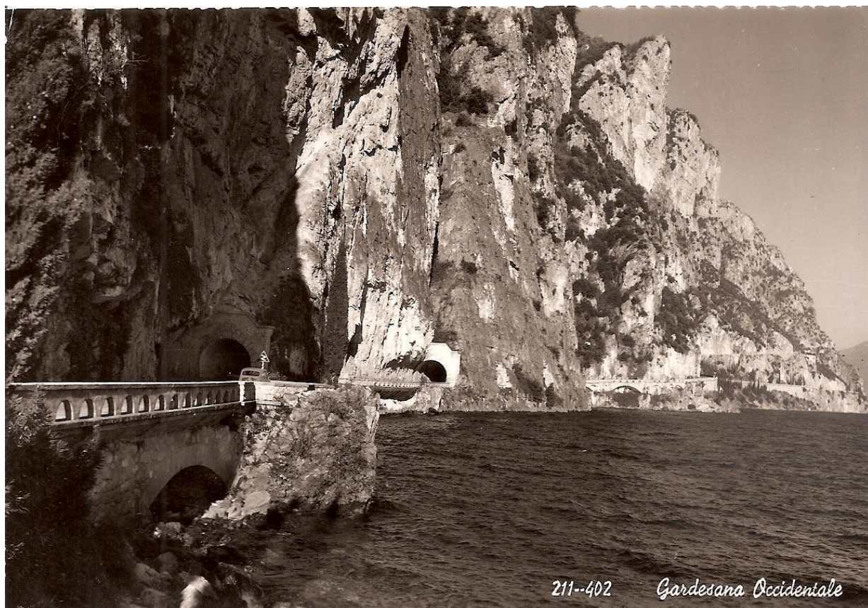
Figura 1.1 - Tratto di Gardesana con gallerie parietali sul livello del Benaco
