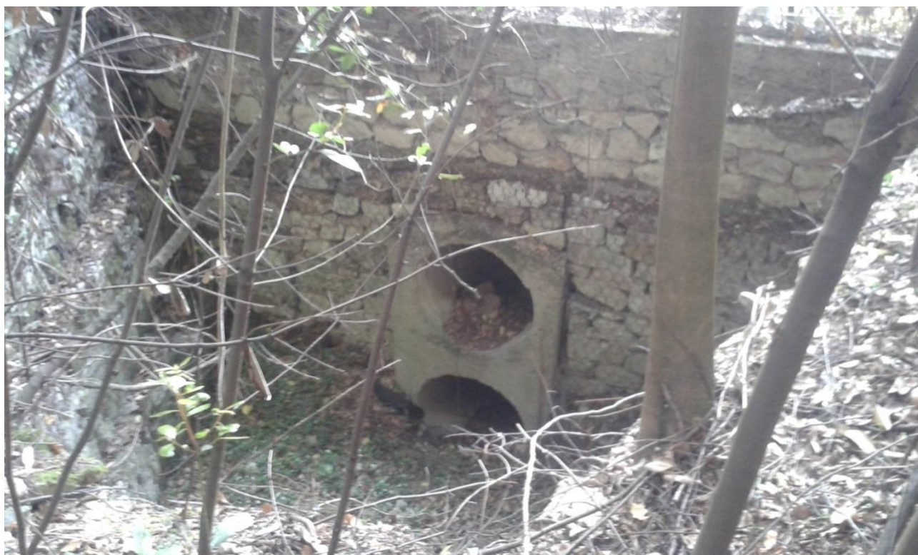
Figura 8.1 – Imbocco tombamento esistente del Fosso Valle della Torre.
