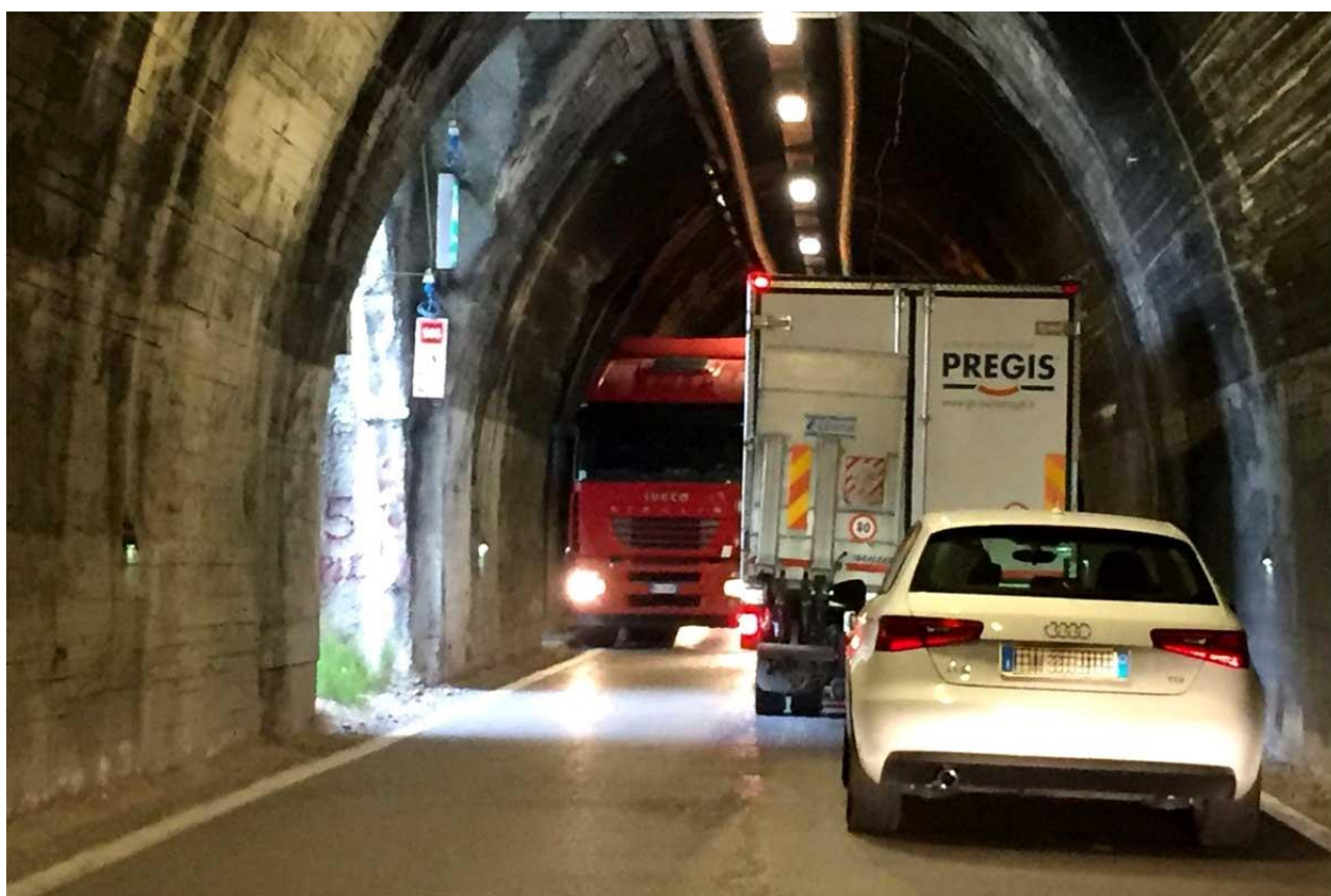
Figura 5.3 – Attuale passaggio contemporaneo mezzi pesanti
