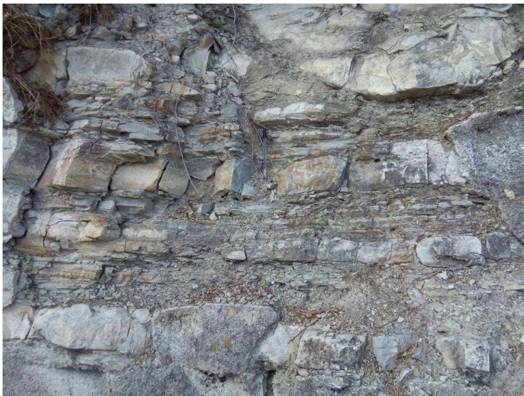
Figura 3 – Affioramento del Medolo lungo il taglio stradale di Via San Giacomo.
