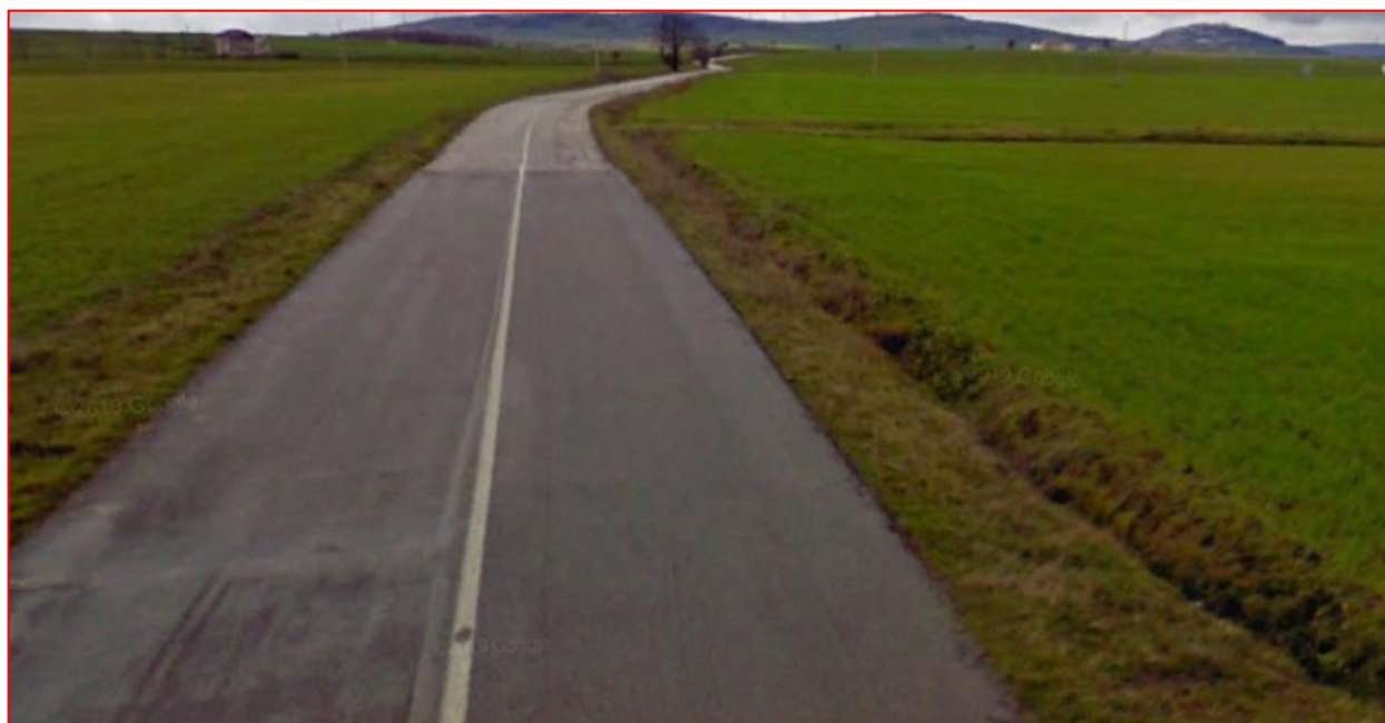
Figura 5-18: Viabilità locale nei pressi nella WTG5
