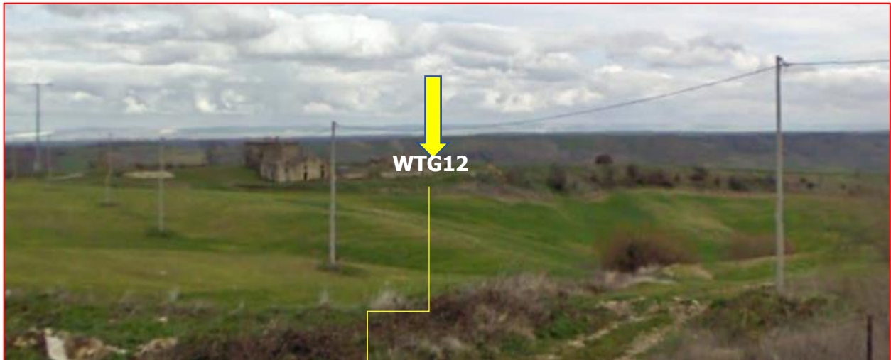
Figura 5-33: Panoramica verso la WTG12
