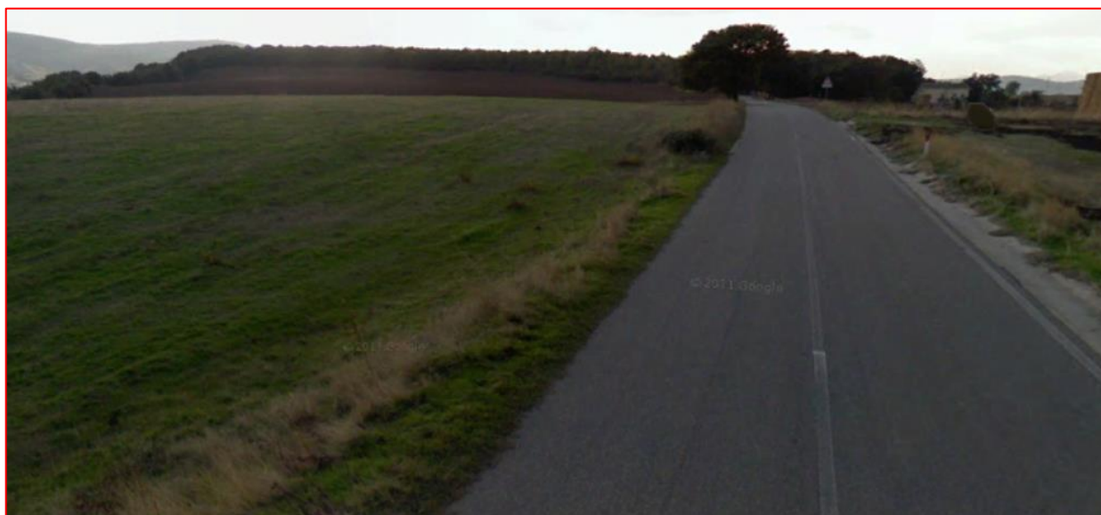
Figura 5-24: Viabilità locale nei pressi nella WTG7
