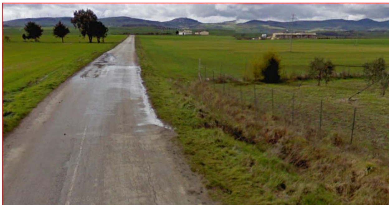
Figura 5-12: Viabilità locale nei pressi della WTG3
