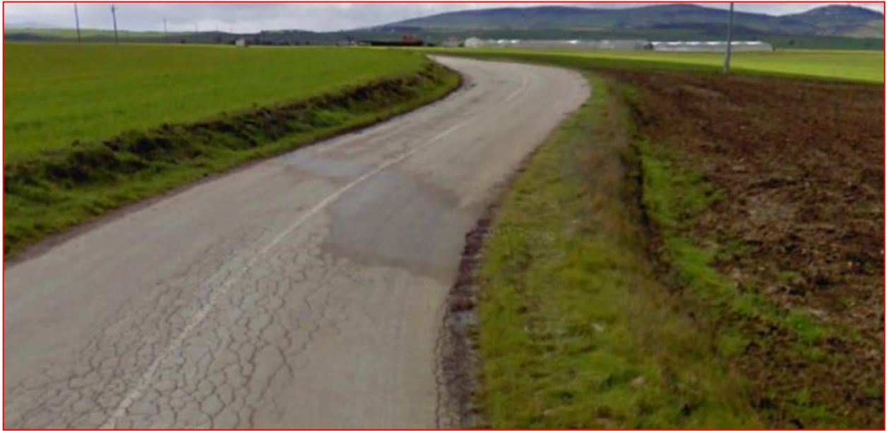
Figura 5-6: Viabilità locale nei pressi nella WTG1
