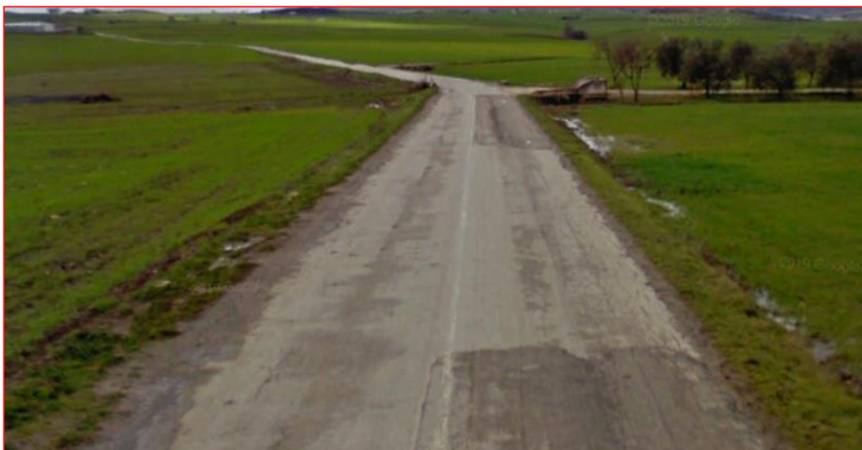
Figura 5-15: Viabilità locale nei pressi nella WTG4
