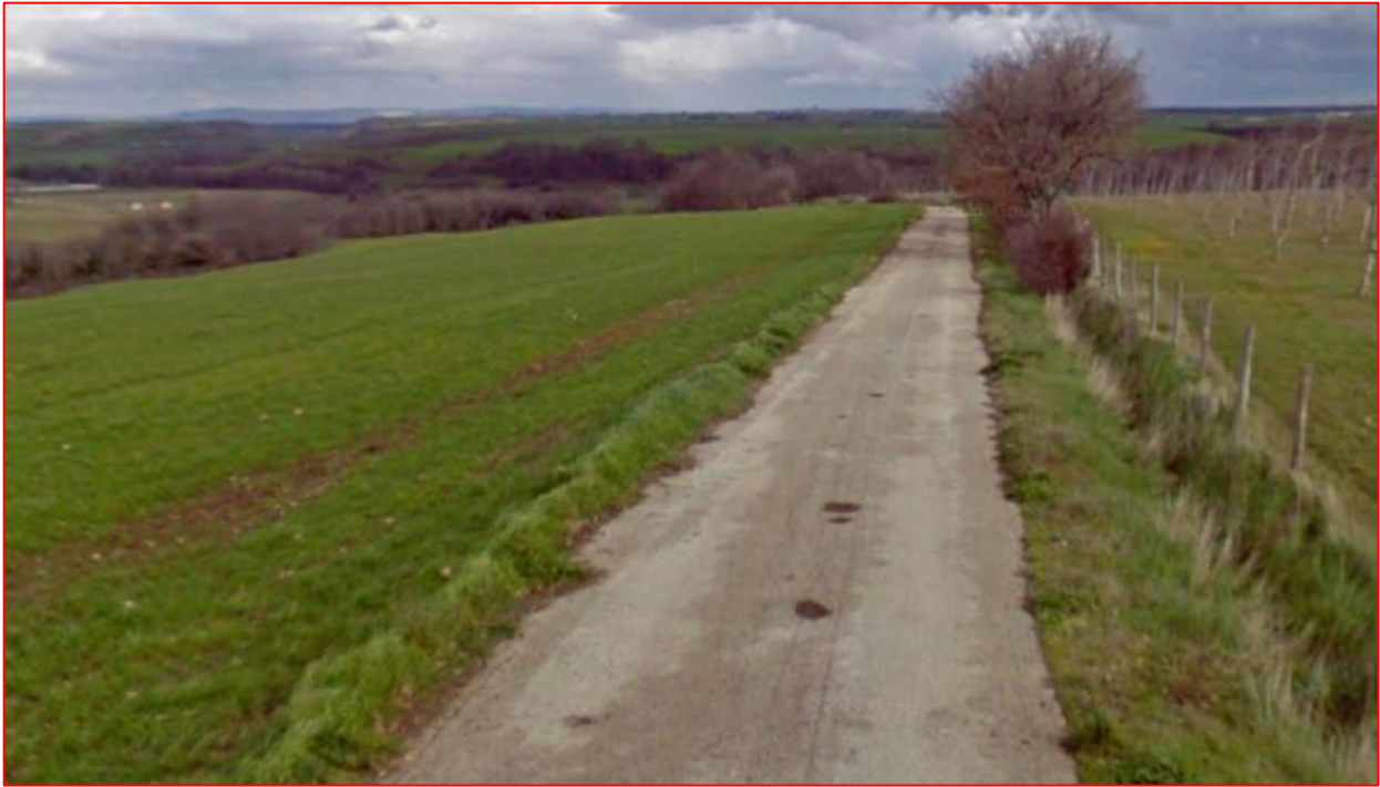
Figura 5-9: Viabilità locale nei pressi nella WTG2
