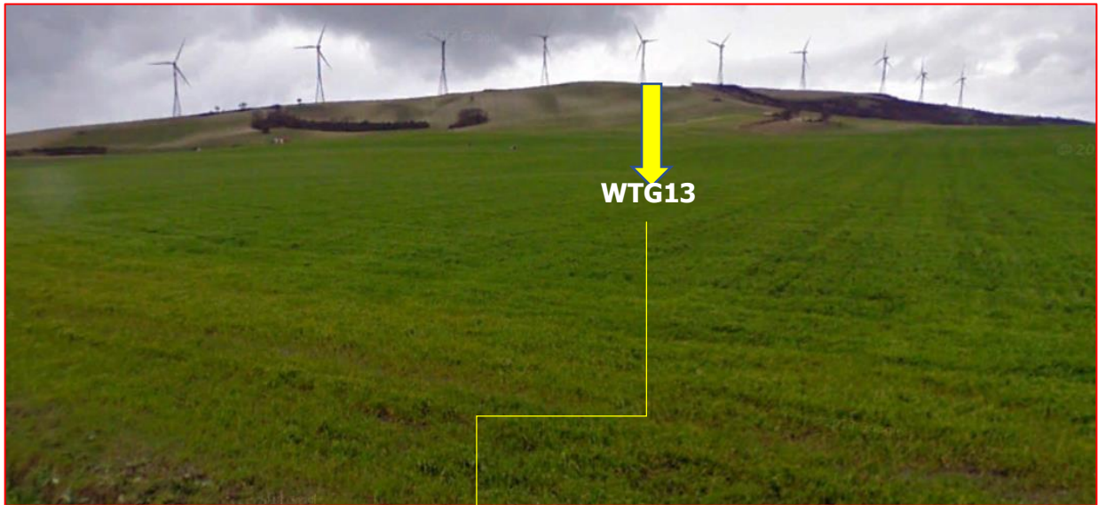
Figura 5-35: Panoramica verso la WTG13
