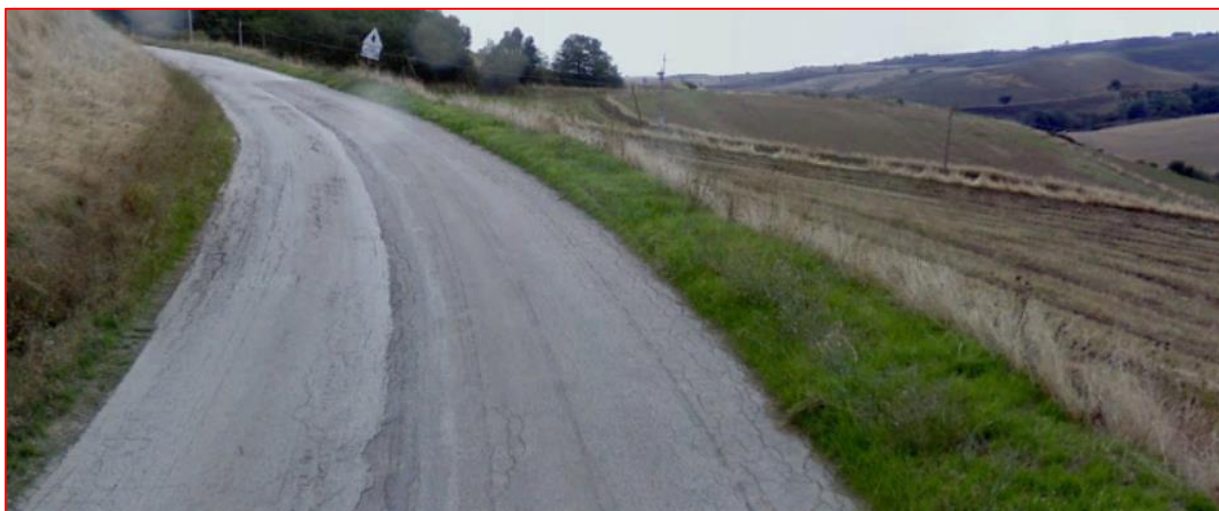
Figura 5-32: Viabilità locale nei pressi della WTG11
