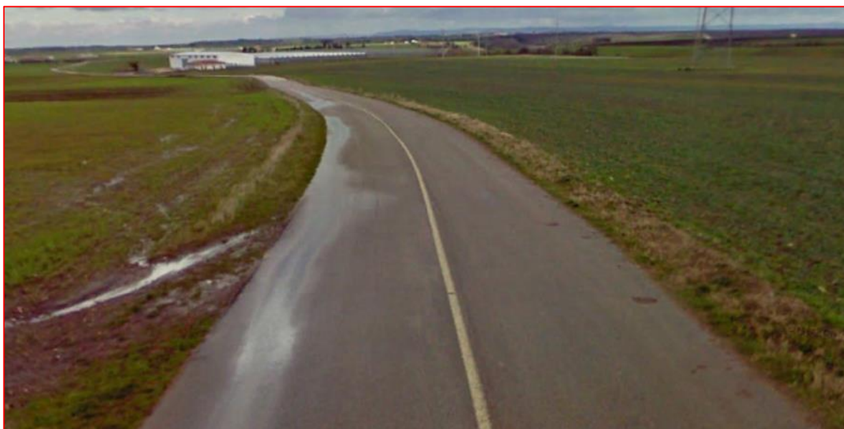
Figura 5-21: Viabilità locale nei pressi della WTG6
