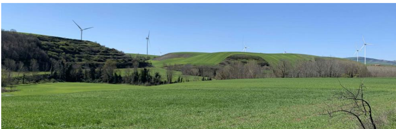
Panoramica post operam da SS168 nei pressi del BCA_088d - n.042 Casalini Sottana - Palazzo San Gervasio (PZ)
