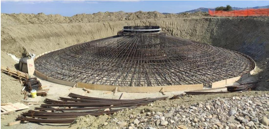
**Figura 4-4: immagine tipo armature plinto**
