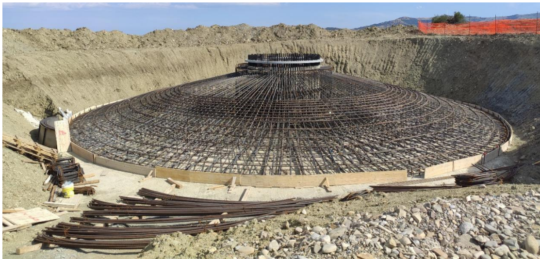
Figura 4: armatura plinto tipo
