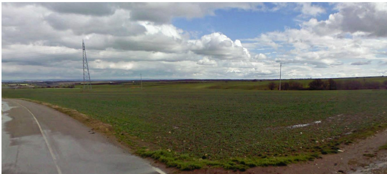
Figura b-3: Foto dell'area di futura Stazione elettrica utente
