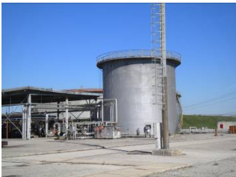
Figura 3-6 Serbatoio accumulo acque reflue e inquinabili da olio K11
