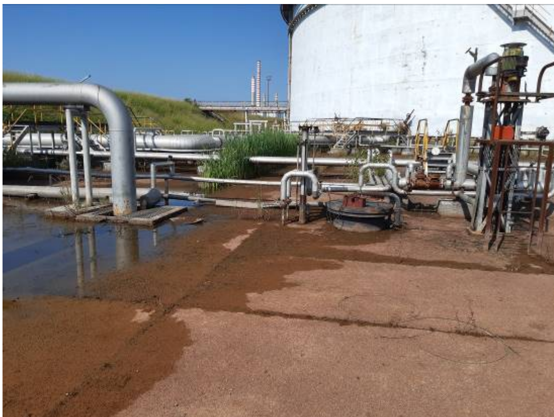
Figura 3-9 Vista della parte fuori terra dei serbatoi interrati
