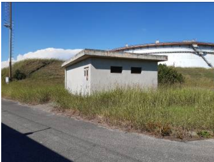
Figura 3-16 - Edificio magazzino materiali antincendio/elettrici
