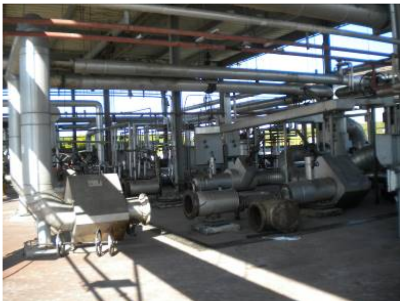
Figura 3-5 Tettoia pompe PN2 - Dettaglio
