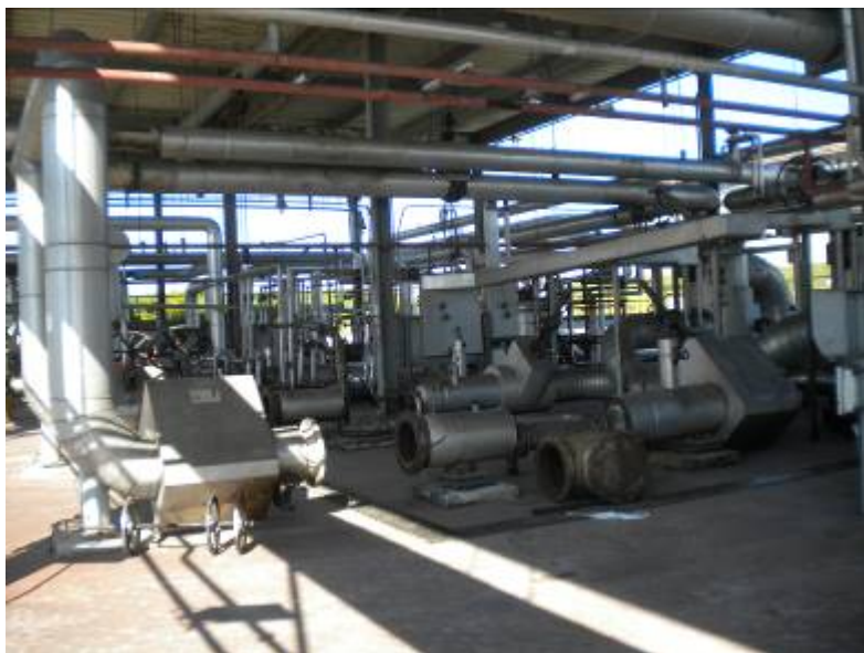
Figura 3-5 Tettoia pompe PN2 - Dettaglio
