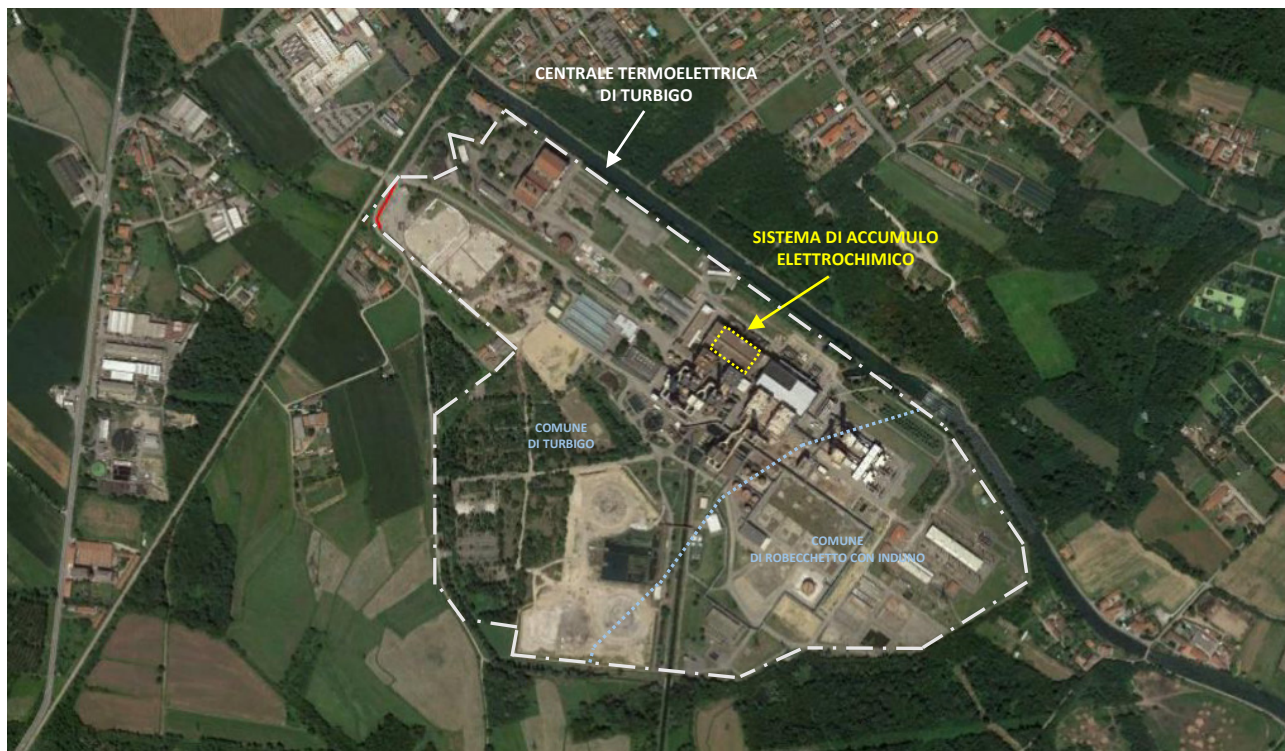
Figura 1: vista della Centrale con l'indicazione dell'area interessata dal sistema di accumulo elettrochimico
