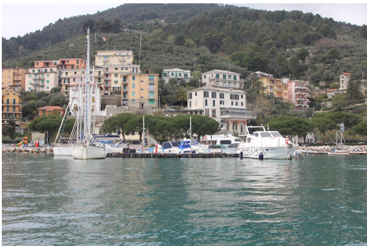
Pontile esistente vista mare
