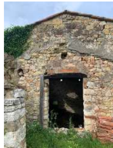
Foto 2: ingresso al fabbricato
