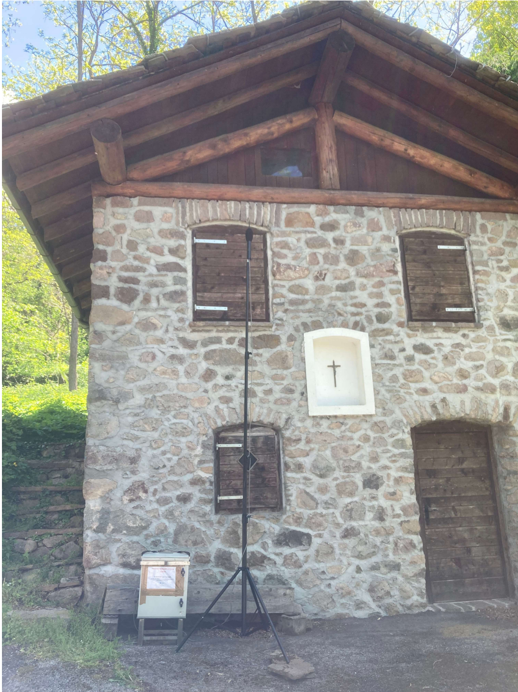
Figura 1 Foto postazione di misura R1
