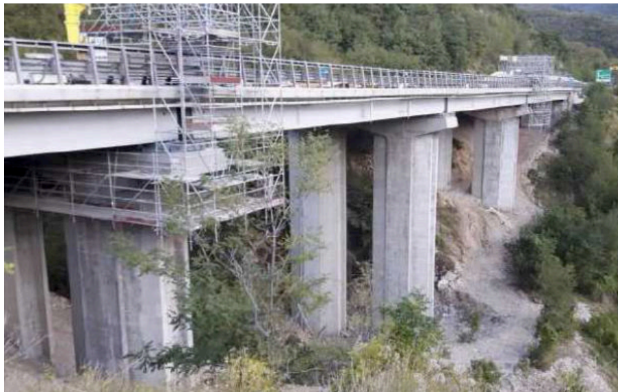
Fig. 2 Viadotto Valle Orsara Fonte: Rapporto Ambientale
