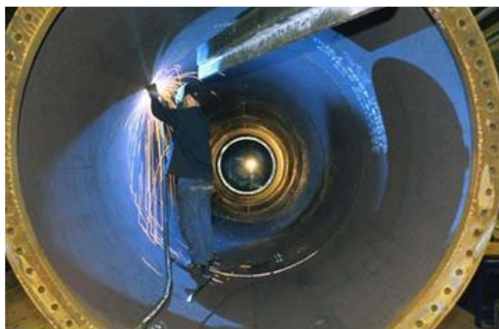
Figura 10 – Interno di una torre
