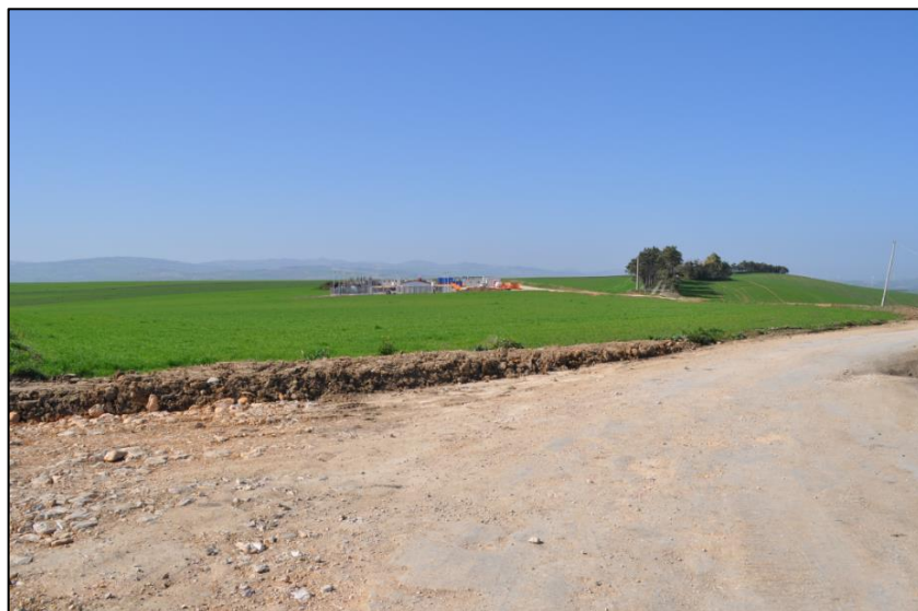
Foto n. 15 – Stazione di elevazione in fase di realizzazione
