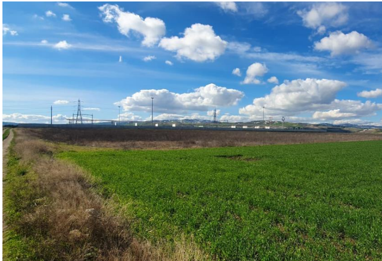
Foto n. 18 - Stazione Terna esistente di Rotello (CB)
