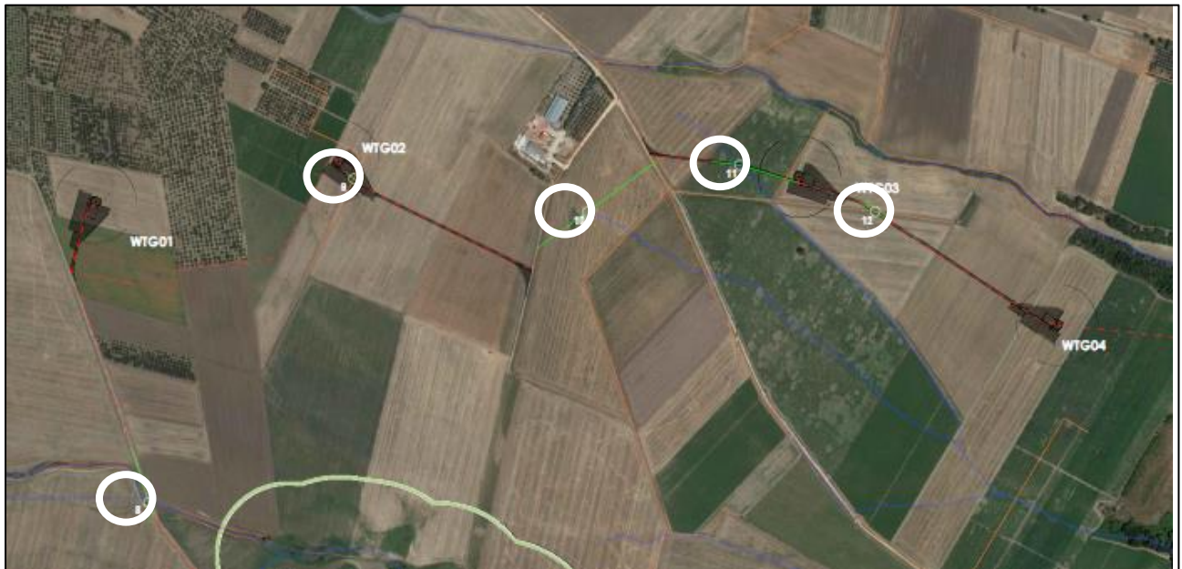
Intersezioni della viabilità con il reticolo e condotta del consorzio di bonifica
