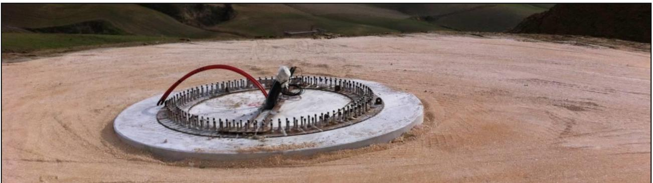
*Fig. 1.5:- Plinto interrato ed anchor cage*
