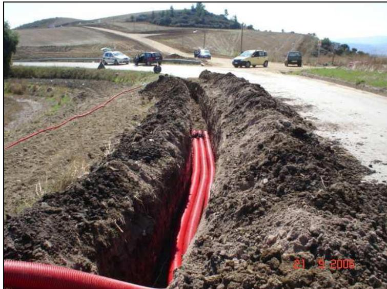
*Fig. 1.8: Foto illustrativa della messa in posa dei cavidotti MT*
