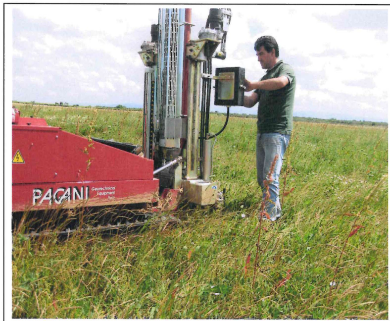
Esecuzione prova penetrometrica
