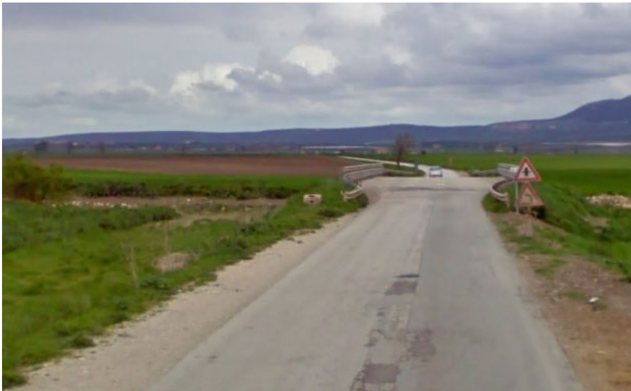
Figura 4 - SP 27 in corrispondenza dell'attraversamento del “Torrente Candelaro” e “Canale Martini”
