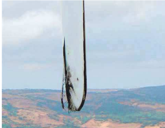
Estremità di pala danneggiata da fulminazione atmosferica.
