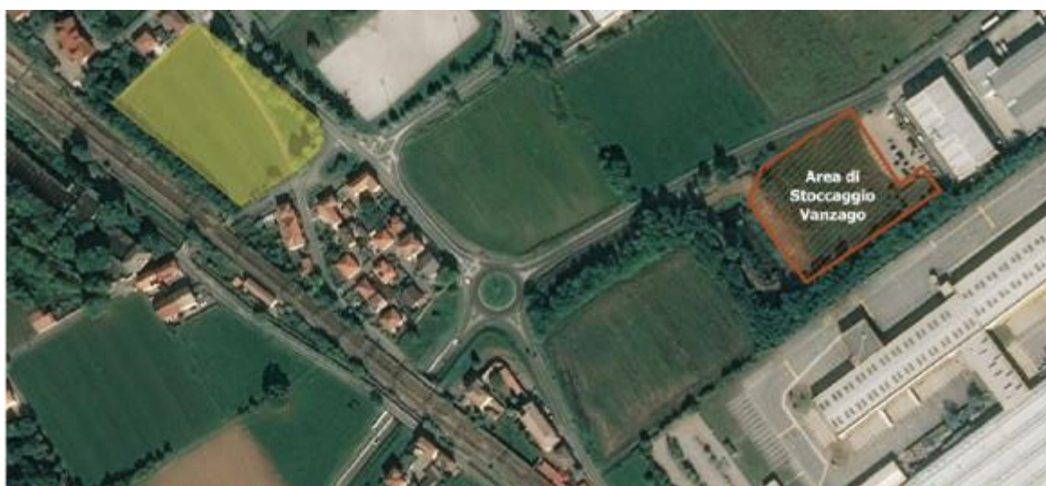
Vista aerea dell'area in cui si inserisce il cantiere, a nord della linea ferroviaria. In giallo l'area che occupava il cantiere nella soluzione del PD 2013.
